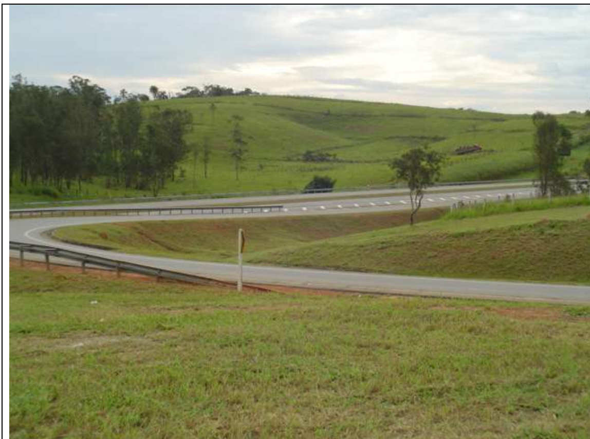
Foto 44 – Alça da Interseção Interligação Dutra - km 61,3
