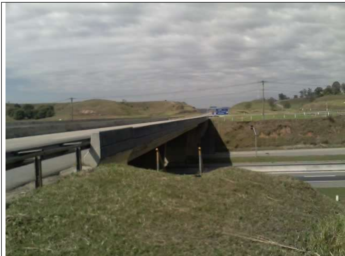
Foto 88 – Passagem sobre BR-116 (sentido SP-070) – km 1,0
