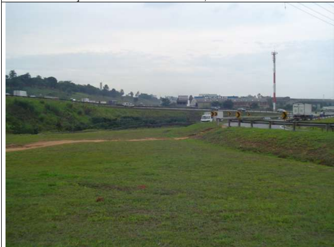
Foto 77 – Interseção Hélio Smidt – Dutra – km 2,0
