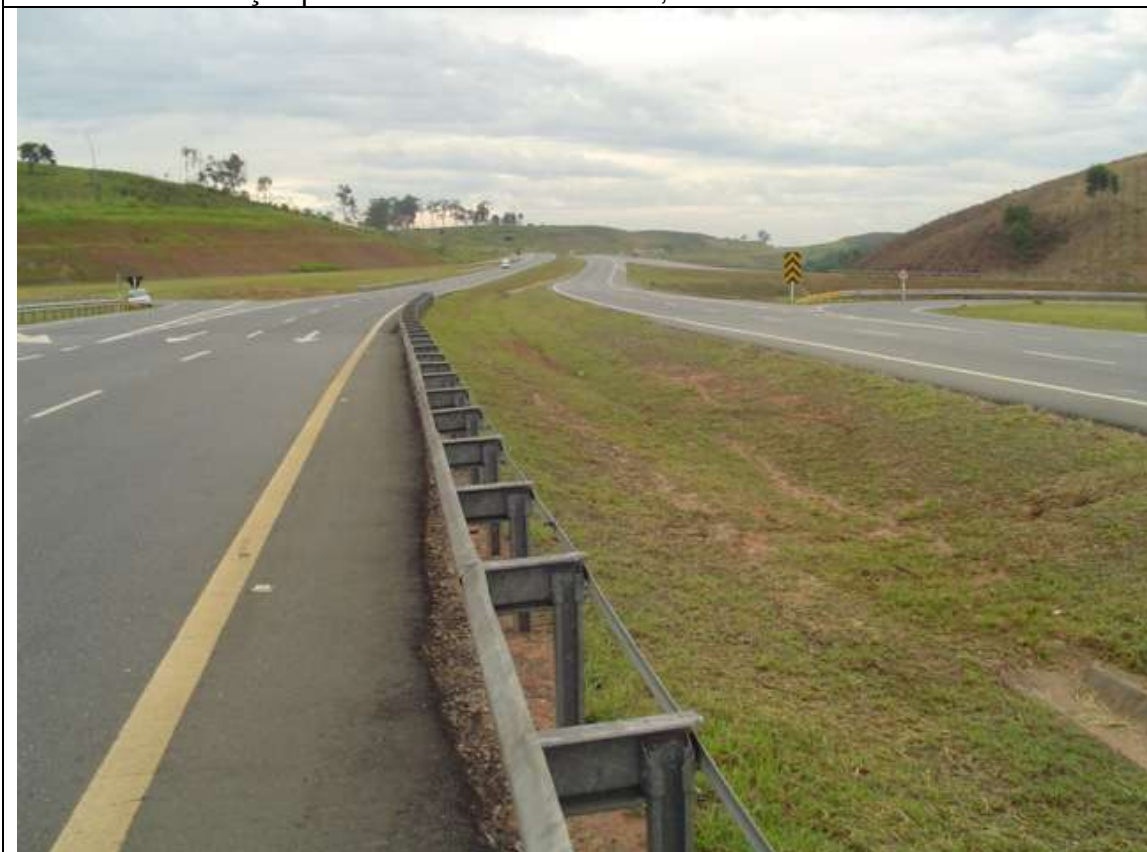
Foto 49 - Interseção Carvalho Pinto – Dom Pedro I – km 73,0 (vista da Dom Pedro I)
