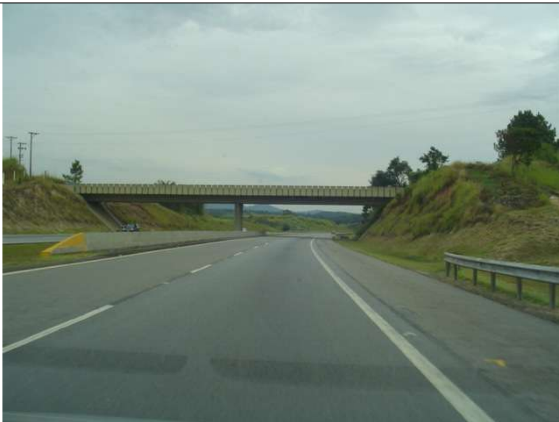
Foto 36 – Passagem Superior (P.S.) – km 53,5 (vista sentido São Paulo)
