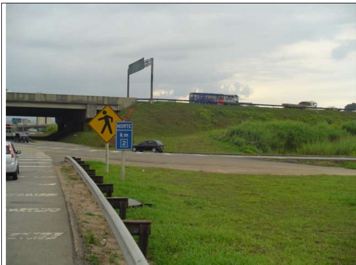
Foto 76 – Interseção Hélio Smidt – Dutra – km 2,0
