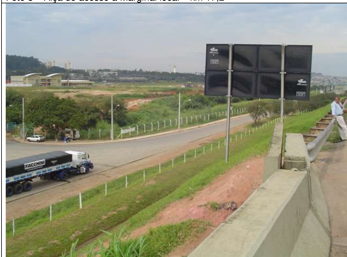
Foto 4 – Final da Marginal e Obra de Arte Especial (Ponte 200m) – km 18,4
