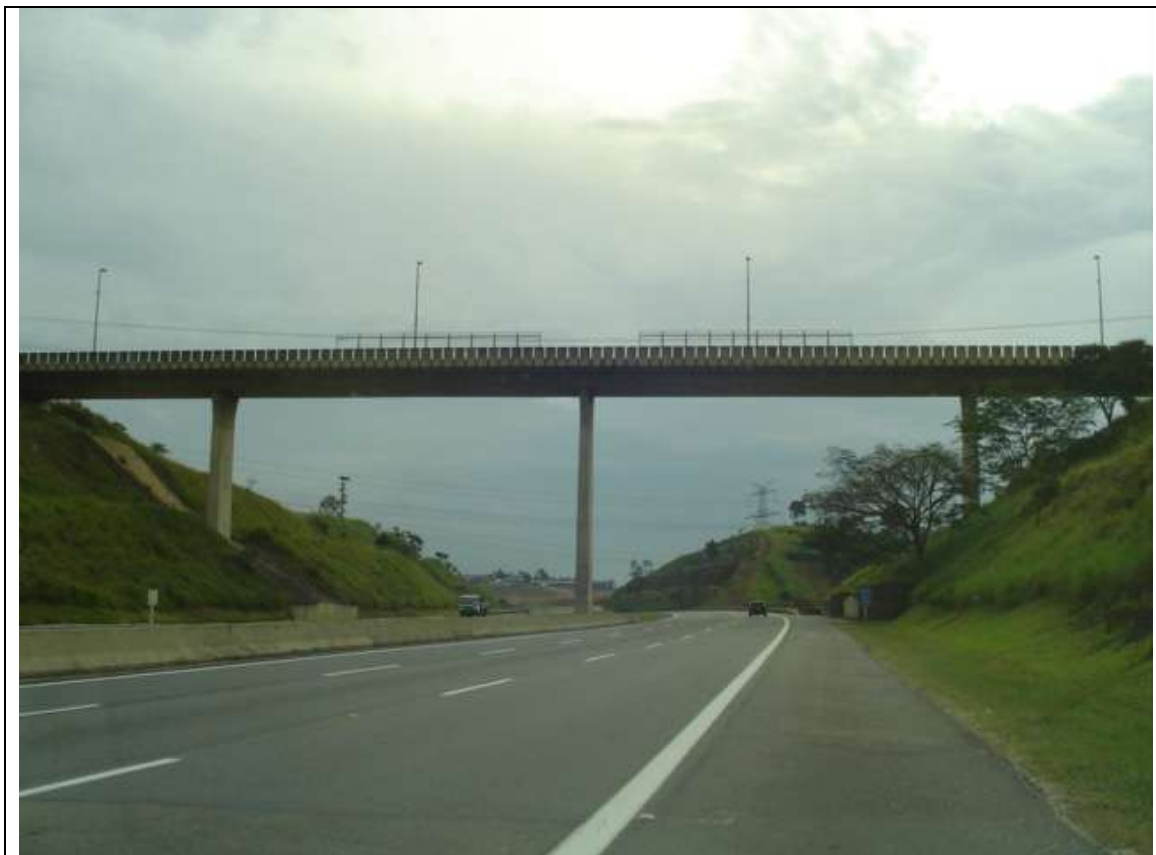
Foto 29 – Passarela – km 42,9 (vista sentido São Paulo)
