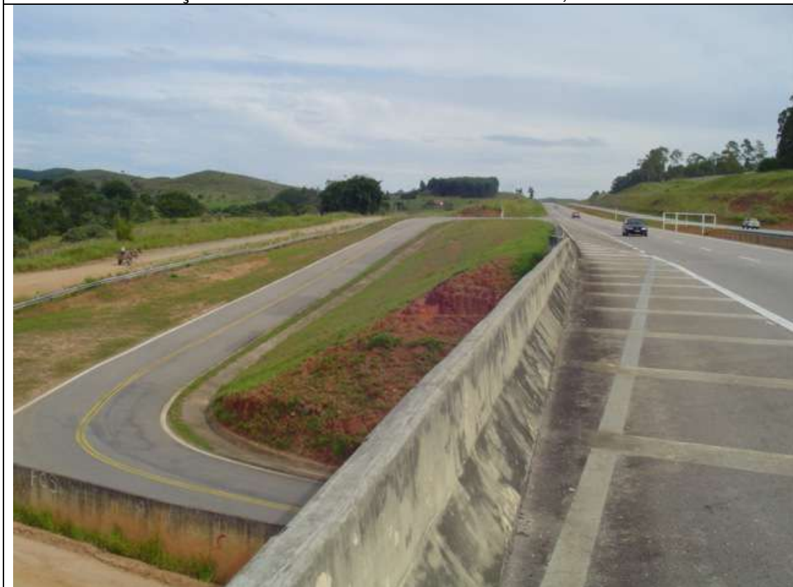
Foto 61 – Saída para Retorno (P.I.) – km 101,8
