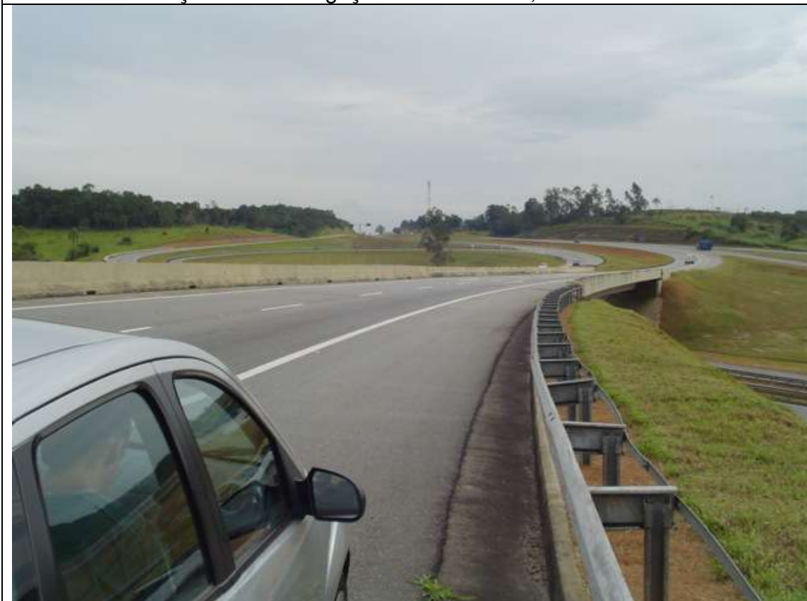
Foto 41 - Interseção com Interligação Dutra - km 61,3
