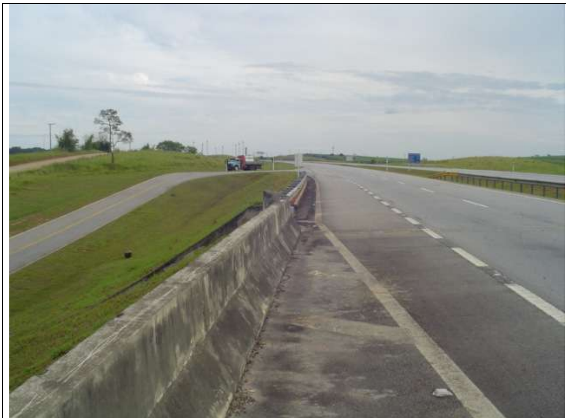
Foto 65 – Saída para Retorno (P.I.) – km 116,1
