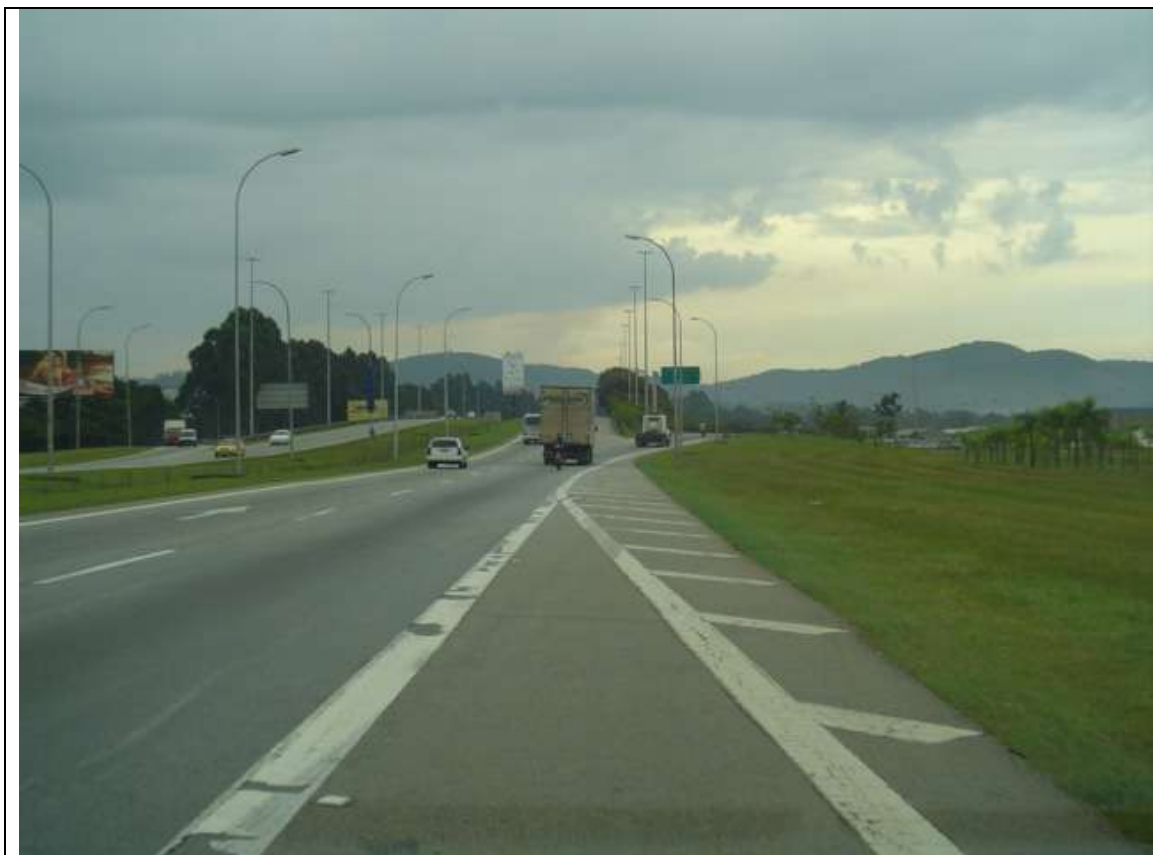
Foto 82 – Saída para Terminal de Carga – km 2,8
