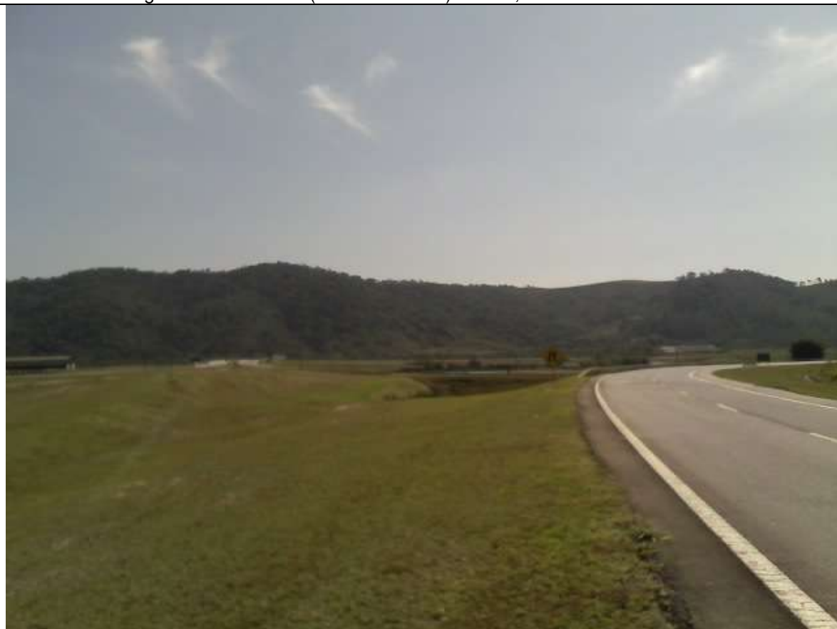
Foto 89 – Vista da chegada à BR-116 – km 4,0
