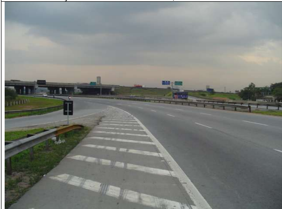
Foto 79 – Interseção Hélio Smidt – Dutra – km 2,0
