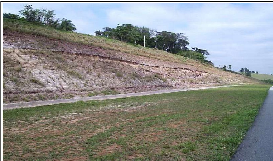
Foto 1 - SP070-CO-13 - Talude com erosão em toda sua extensão Falta vegetação e assoreamento na drenagem
