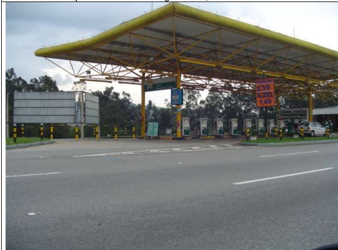
Foto 83 – Auto Posto no canteiro central – km 4,0
