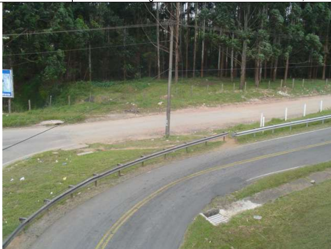
Foto 20 – Chegada da Marginal de terra à saída para acesso a Marginal local - km 34,4
