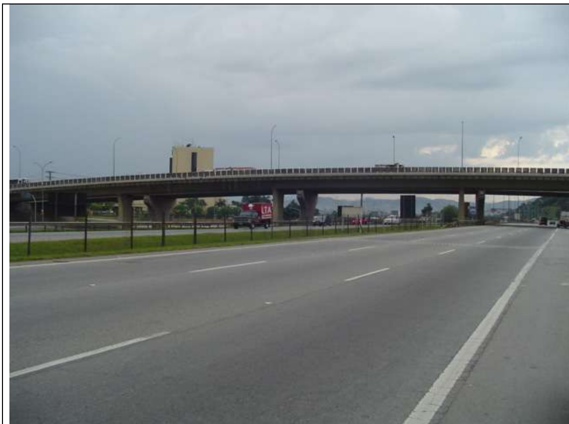
Foto 80 - Passagem Superior (P.S.) – km 2,4 (início do trecho sob jurisdição do DER)
