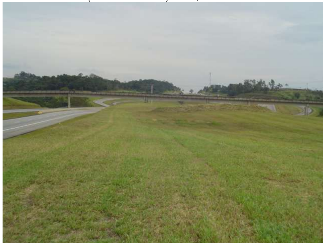
Foto 43 - Passarela (vista sentido São Paulo) km 61,5
