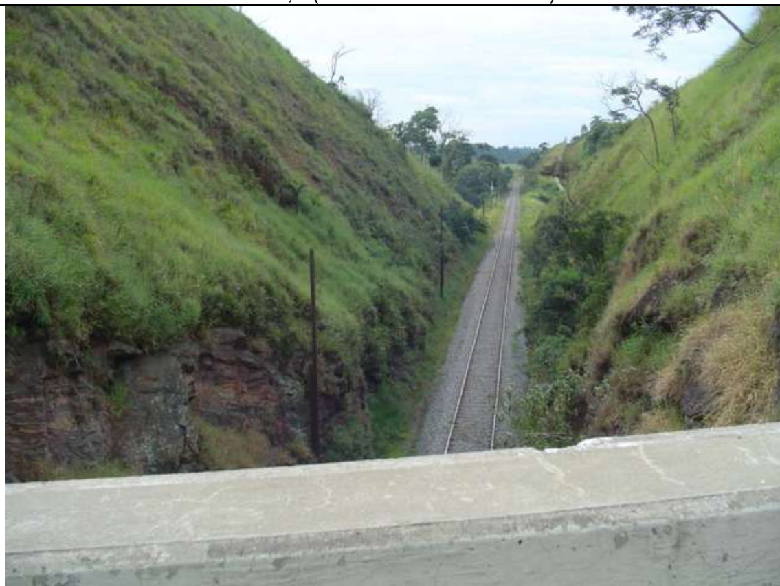
Foto 30 – Travessia de Ferrovia – (P.I.) – km 43,9
