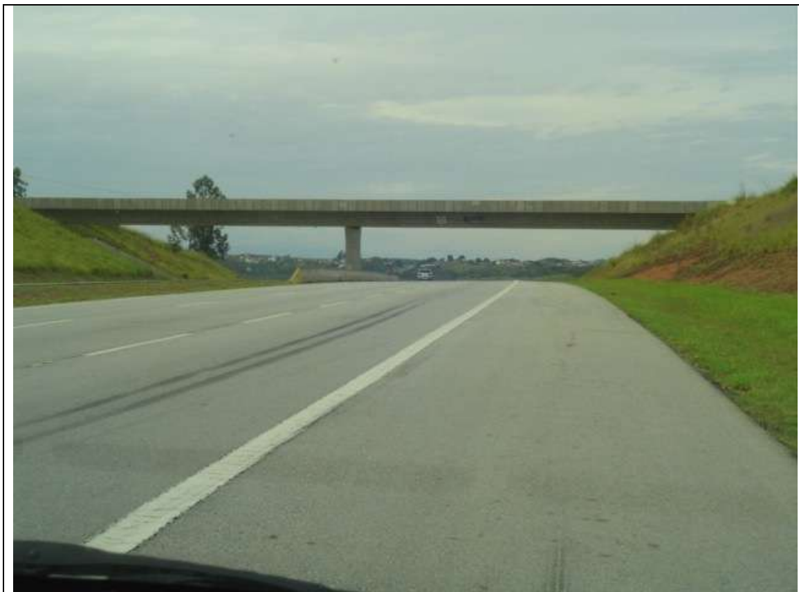
Foto 69 – Passagem Superior (P.S.) – km 119,3
