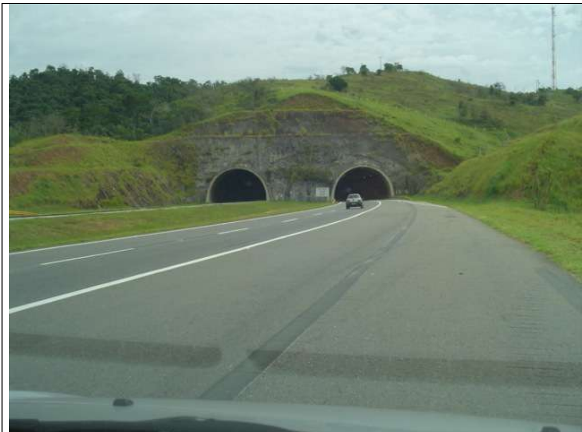
Foto 56 – Carvalho Pinto - Túnel 3 (vista sentido São Paulo) – km 80
