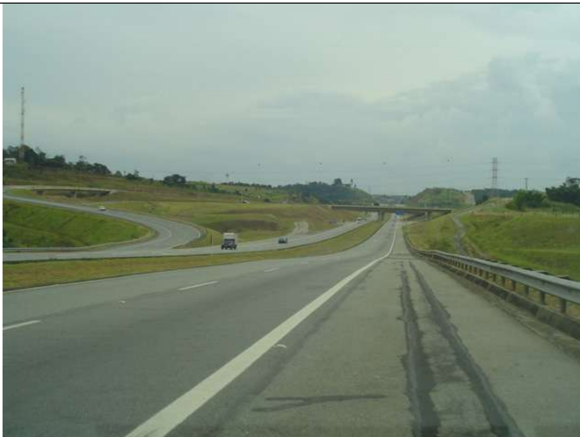
Foto 32 – Interseção Ayrton Senna – Mogi-Dutra – km 45,3 (vista sentido São Paulo)
