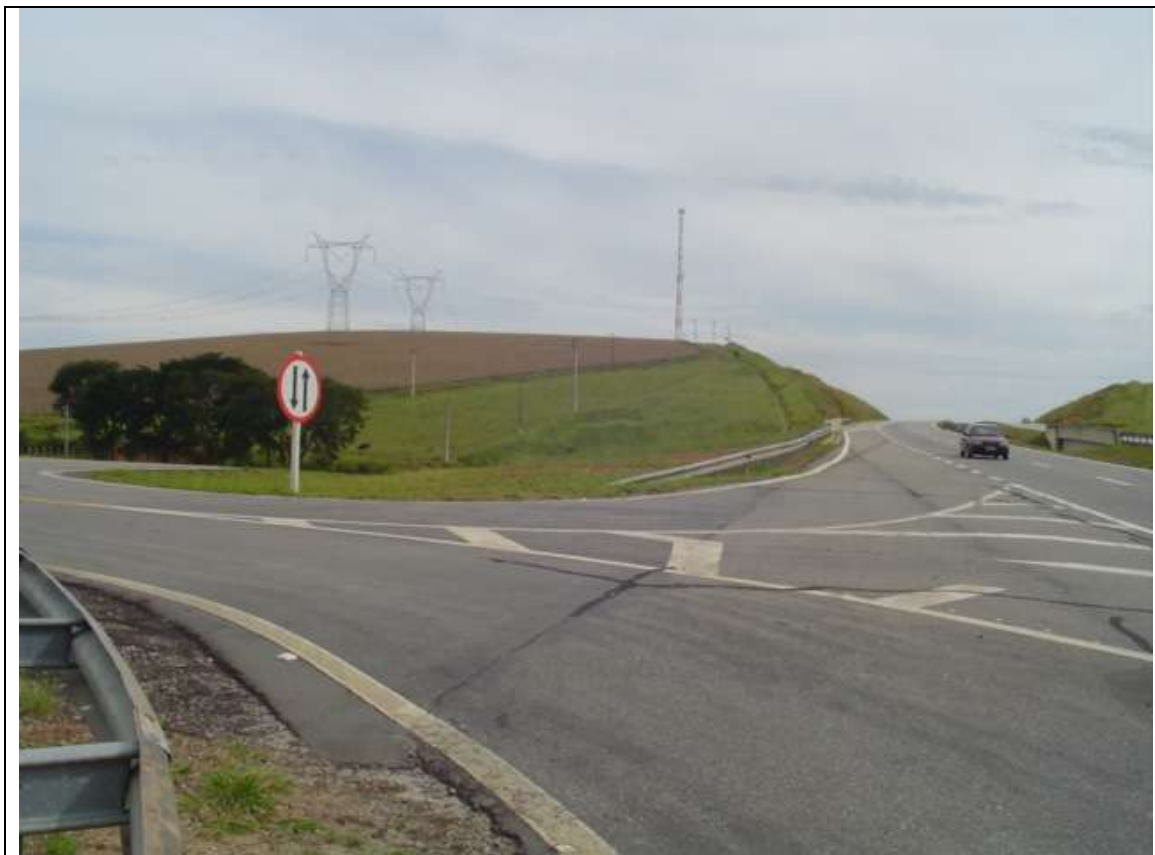
Foto 62 – Saída para Retorno (P.I.) – km 106,5
