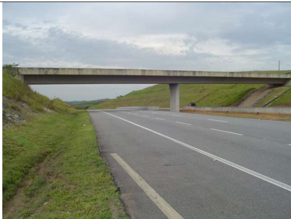
Foto 46 – Passagem Superior (P.S.) – km 64,4
