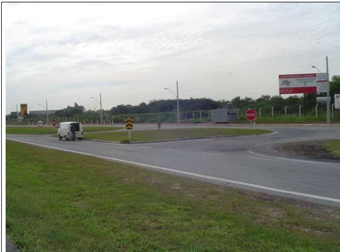
Foto 3 – Alça de acesso a Marginal local – km 17,2
