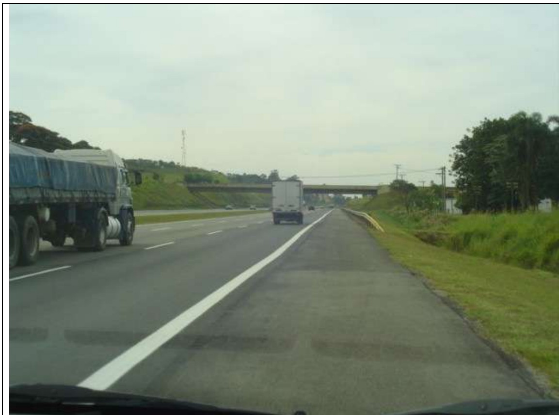
Foto 27 – Passagem Superior (P.S.) - km 39,8
