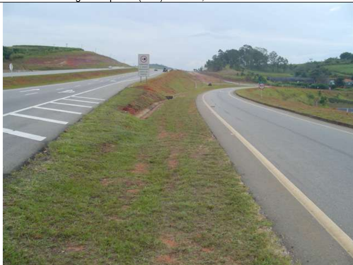
Foto 47 – Interseção para Guararema – km 69,0 (vista sentido São Paulo)
