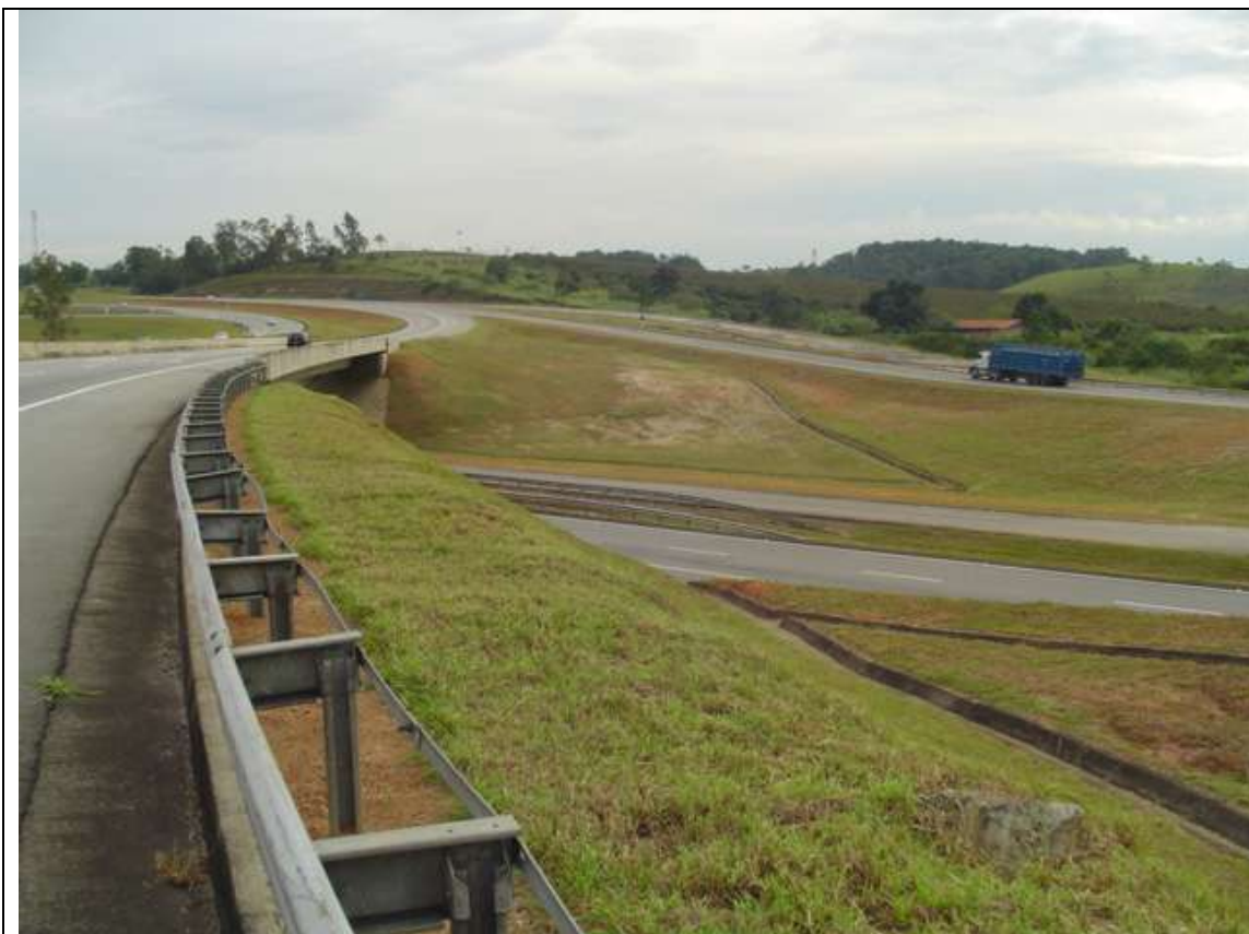
Foto 40 - Interseção com Interligação Dutra - km 61,3
