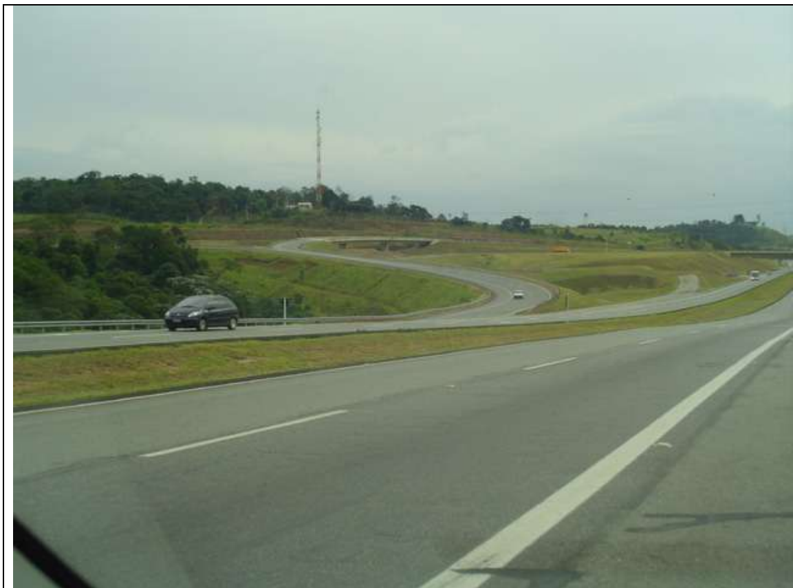
Foto 31 – Interseção Ayrton Senna – Mogi-Dutra – km 45,3 (vista sentido São Paulo)
