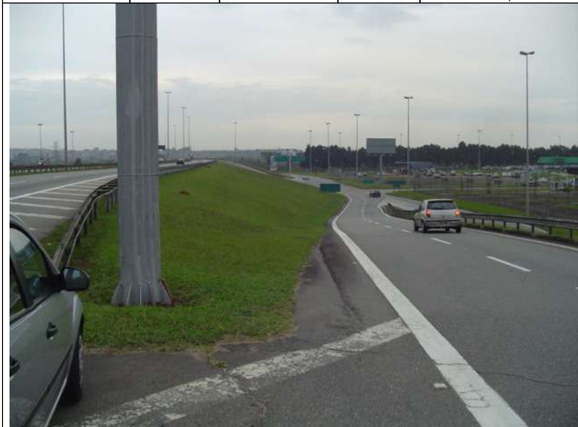
Foto 85 – Saída para o Estacionamento do Aeroporto – km 4,6
