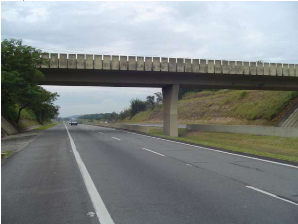
Foto 33 – Passagem Superior (P.S.) – km 48,2
