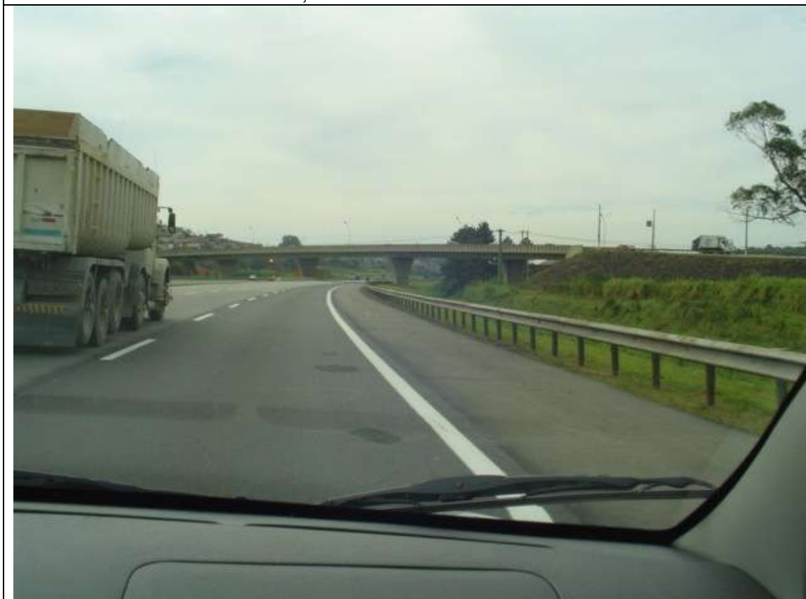
Foto 26 – Passagem Superior (P.S.) - km 38,1
