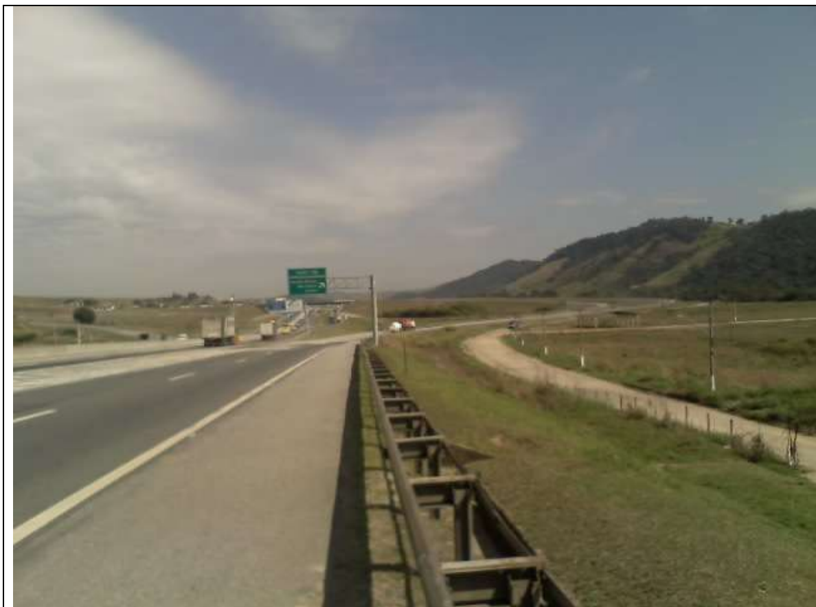
Foto 86 – Início do trecho em alça de acesso à interligação – km 0,0
