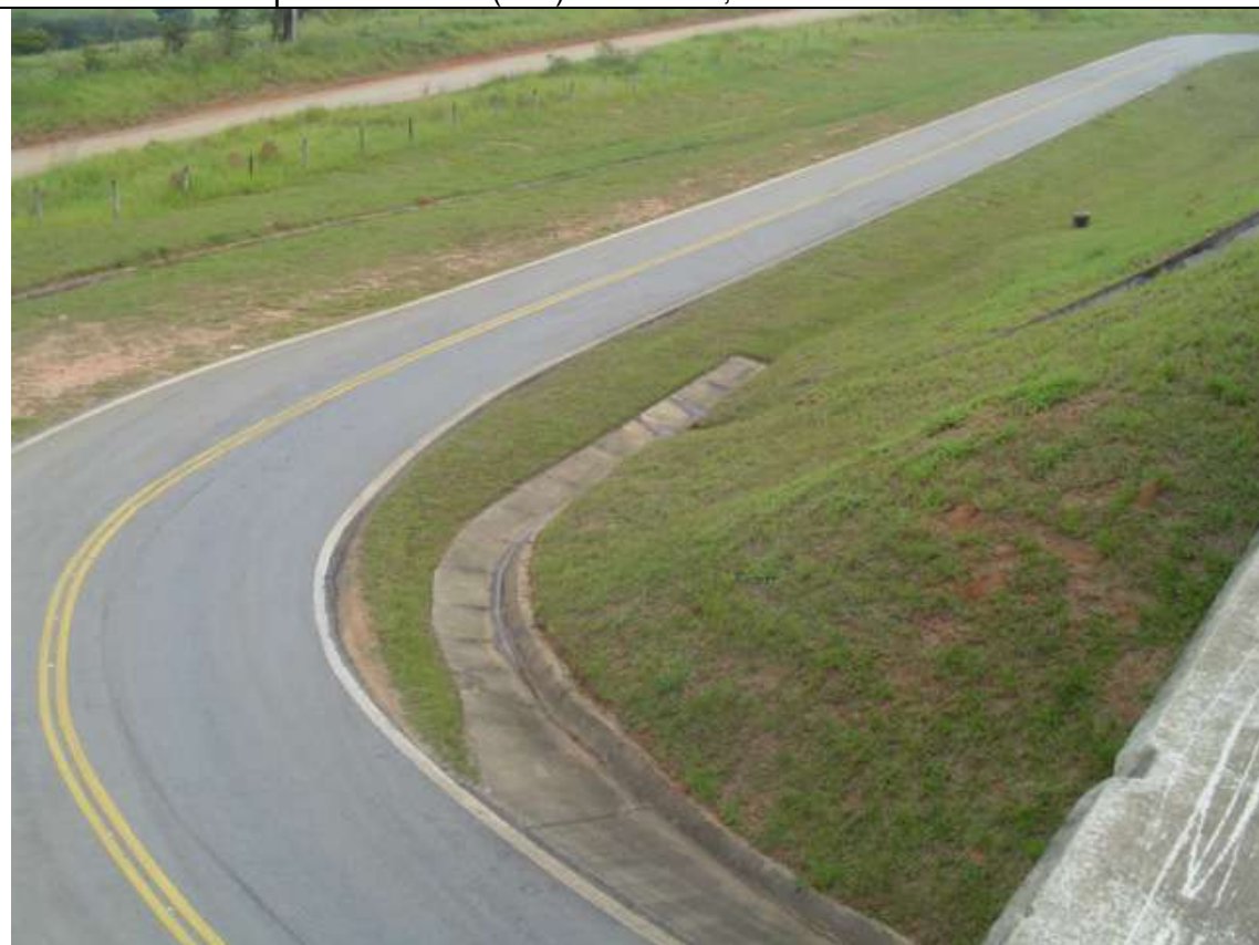
Foto 66 – Saída para Retorno (P.I.) – km 116,1
