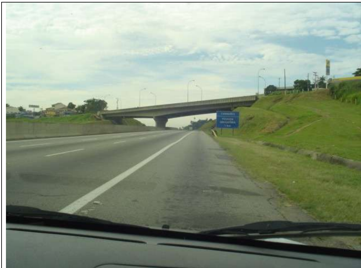
Foto 13 – Passagem Superior (P.S.) – km 27,2
