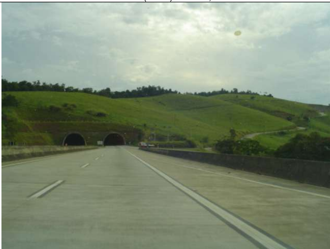
Foto 55 – Túnel 2 – km 76,4 e O.A.E. - km 77 – vista sentido São Paulo
