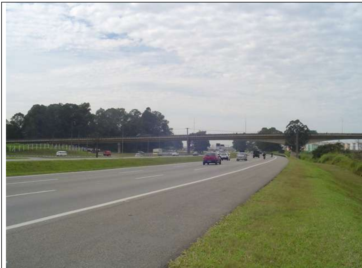
Foto 7 – Passagem Superior (P.S.) – km 21,8
