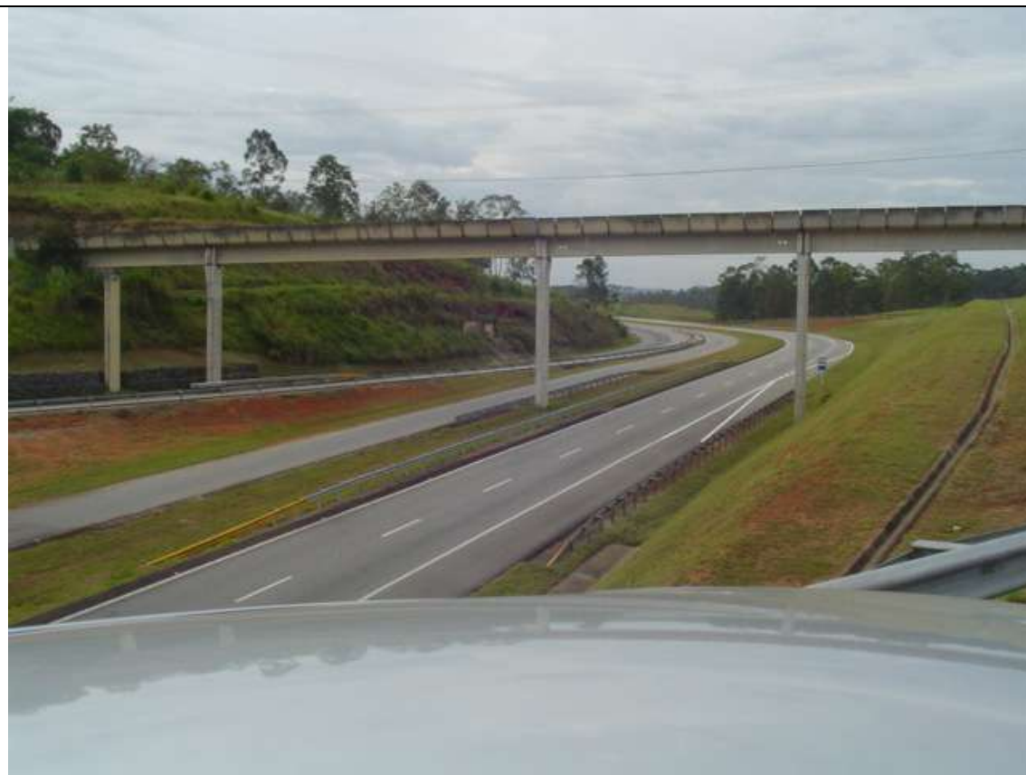
Foto 42 - Passarela (vista sentido Dutra) km 61,5
