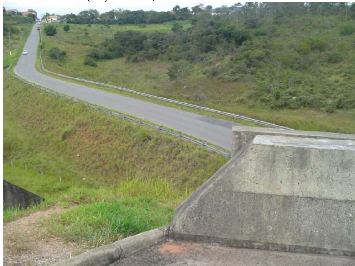
Foto 72 – Passagem para José Aguiar Vieira (P.I.) – km 121,6
