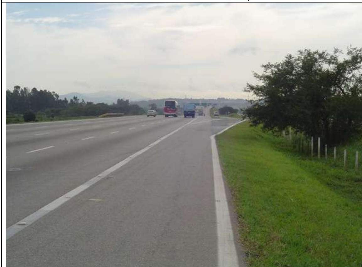
Foto 2 – Alça de acesso a Marginal local – km 17,0
