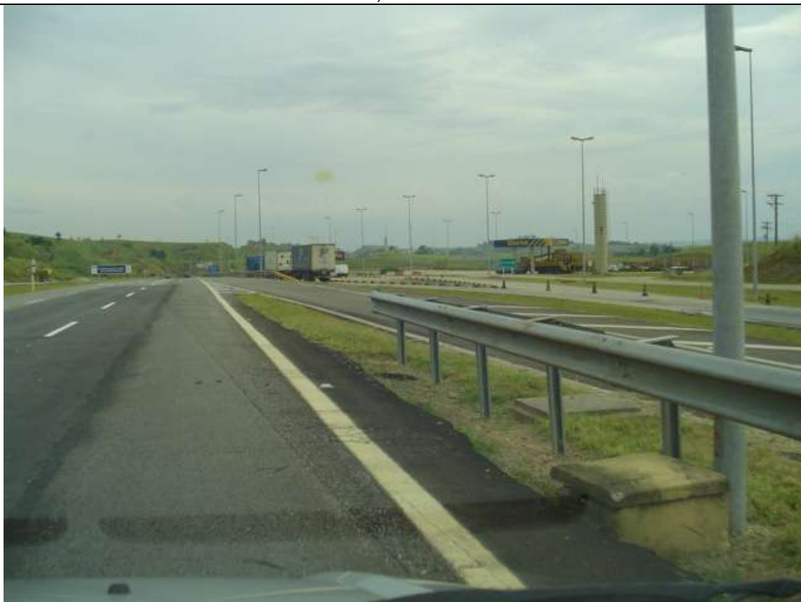
Foto 39 – Balança em operação – km 59,0 (vista sentido São Paulo)
