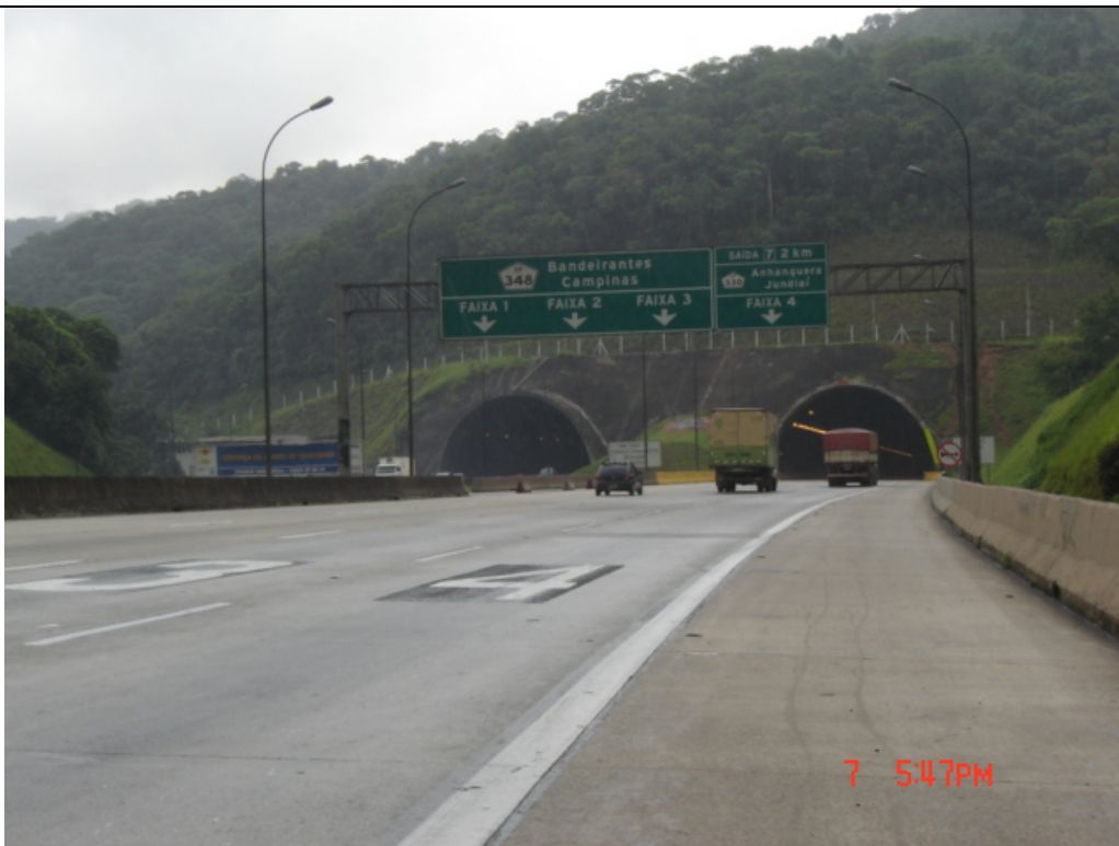
Vista do Portal dos túneis TE-1 e TI-1 (vista sentido Perus) - km 9,1
