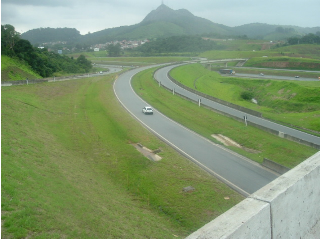
Vista das alças para Rod. dos Bandeirantes: sentido SP (esq.) da pista externa; e sentido Campinas (dir.) da pista externa do Rodoanel
