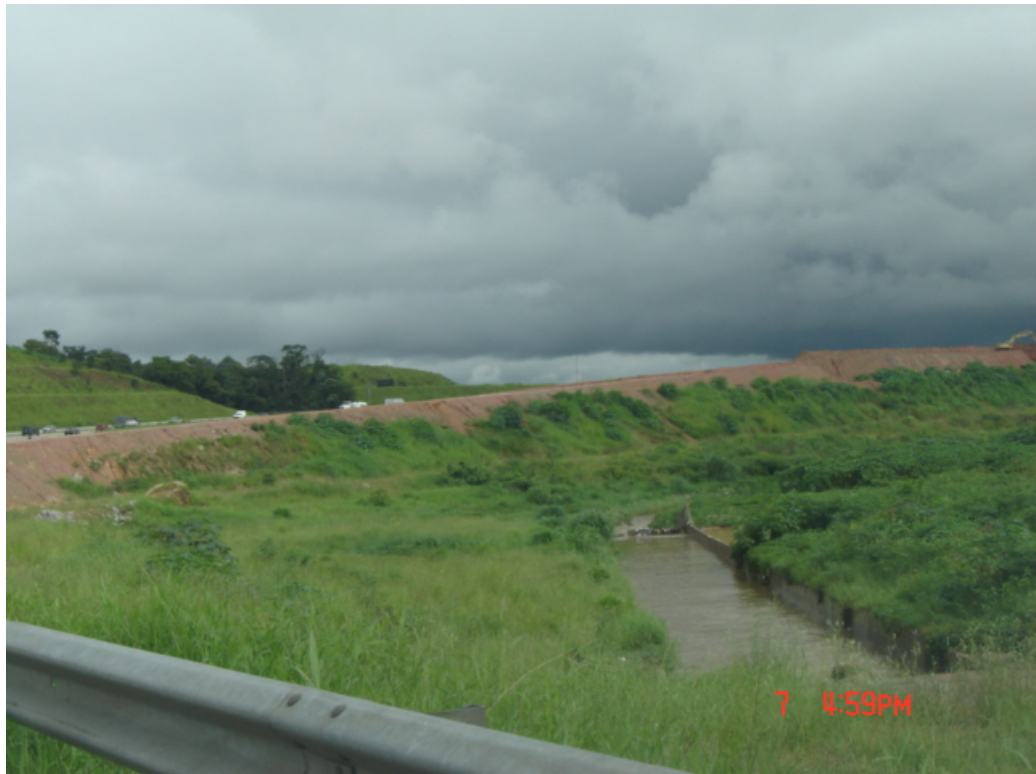
Área da Bacia de Detenção 2 (pista interna) – km 21,2
