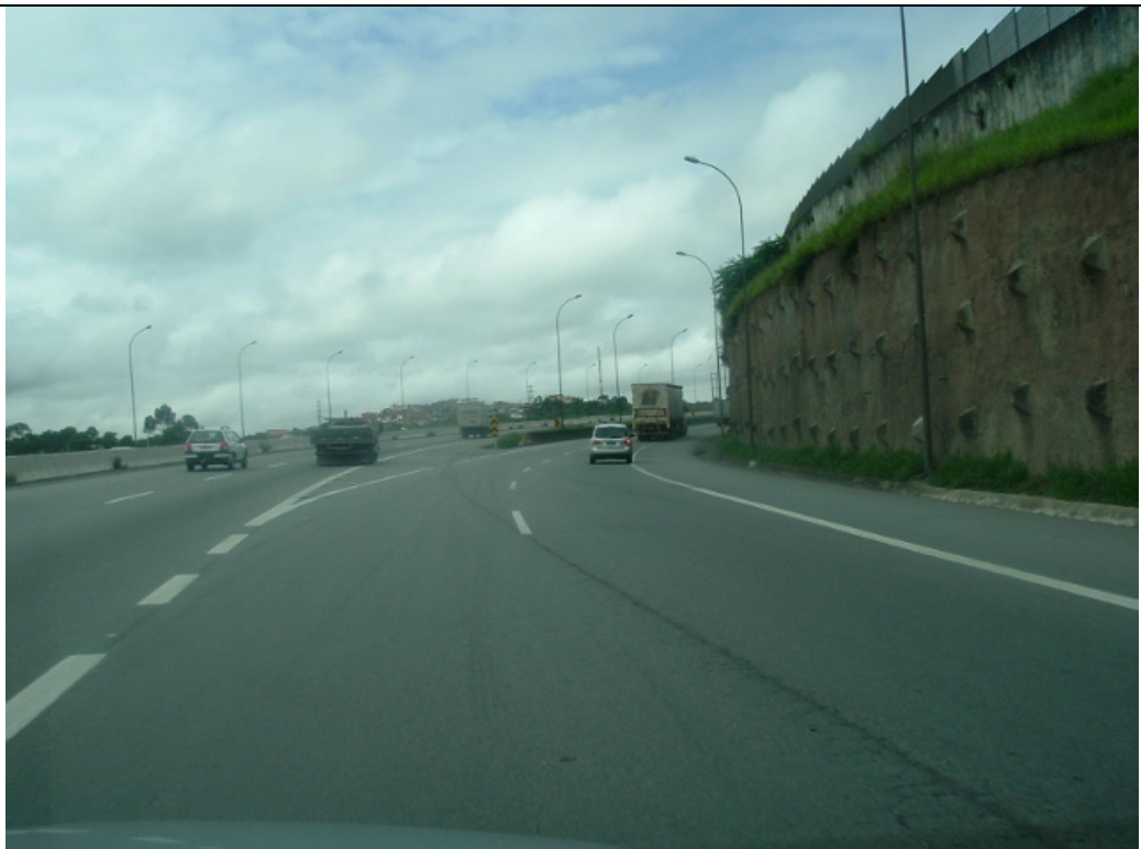
Acesso ao Rodoanel pela Rod. Régis Bittencourt (sentido Taboão da Serra)
