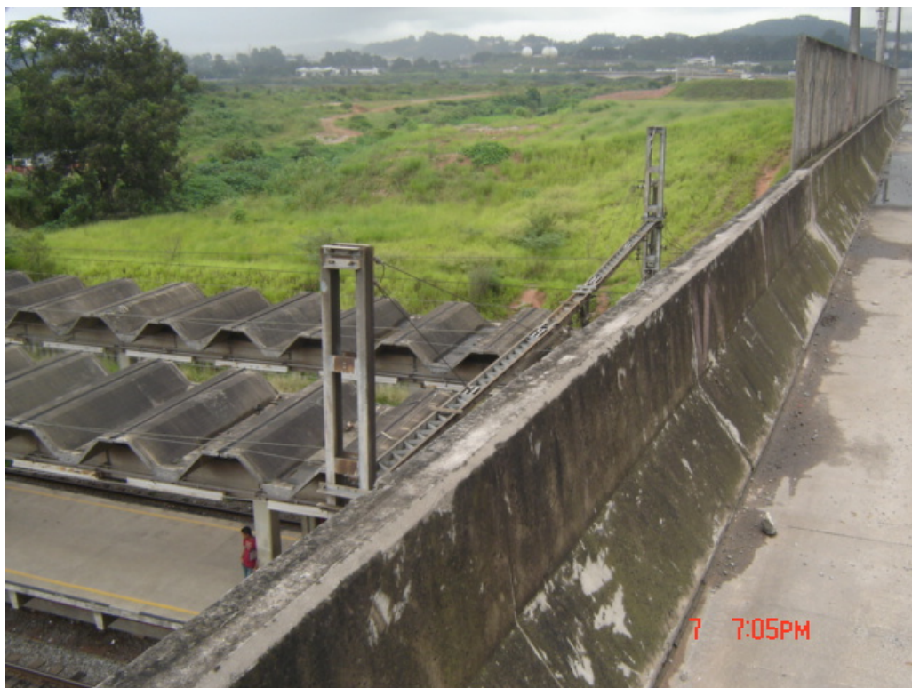
Travessia sobre CPTM e Av. dos Autonomistas (pista externa) – km 16,1
