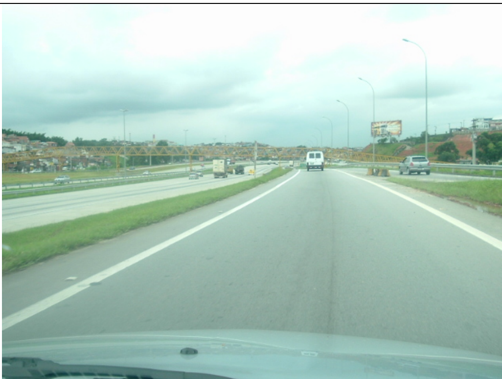
Alça de acesso ao Rodoanel (pista interna)
