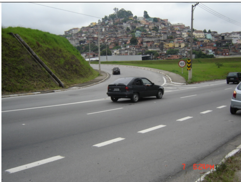
Alça de retorno à Av. Raimundo Pereira de Magalhães (sentido Centro SP)
