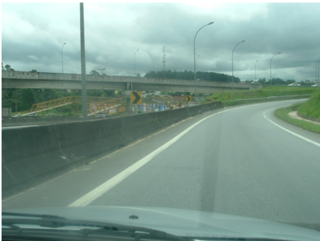
Alça da Rod. Raposo Tavares (sentido Cotia) para o Rodoanel (pista externa) e ao fundo O.A.E. alça da pista externa para a Rod. Raposo Tavares (sentido SP)
