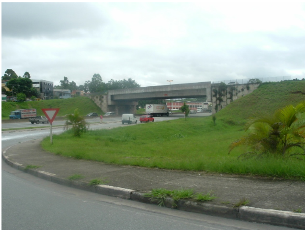
Retorno sobre a Rod. Raposo Tavares e acesso às marginais (vista sentido Cotia)
