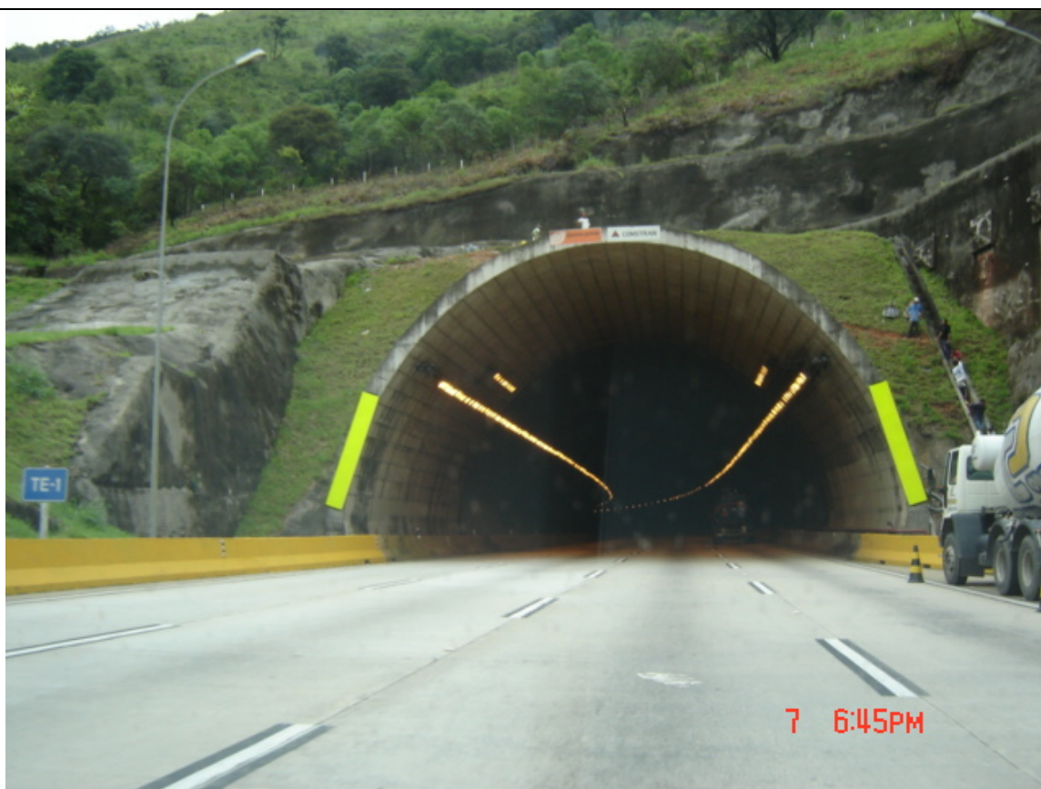
Detalhe do Portal do túnel TE-1 (pista externa) - km 7,4
