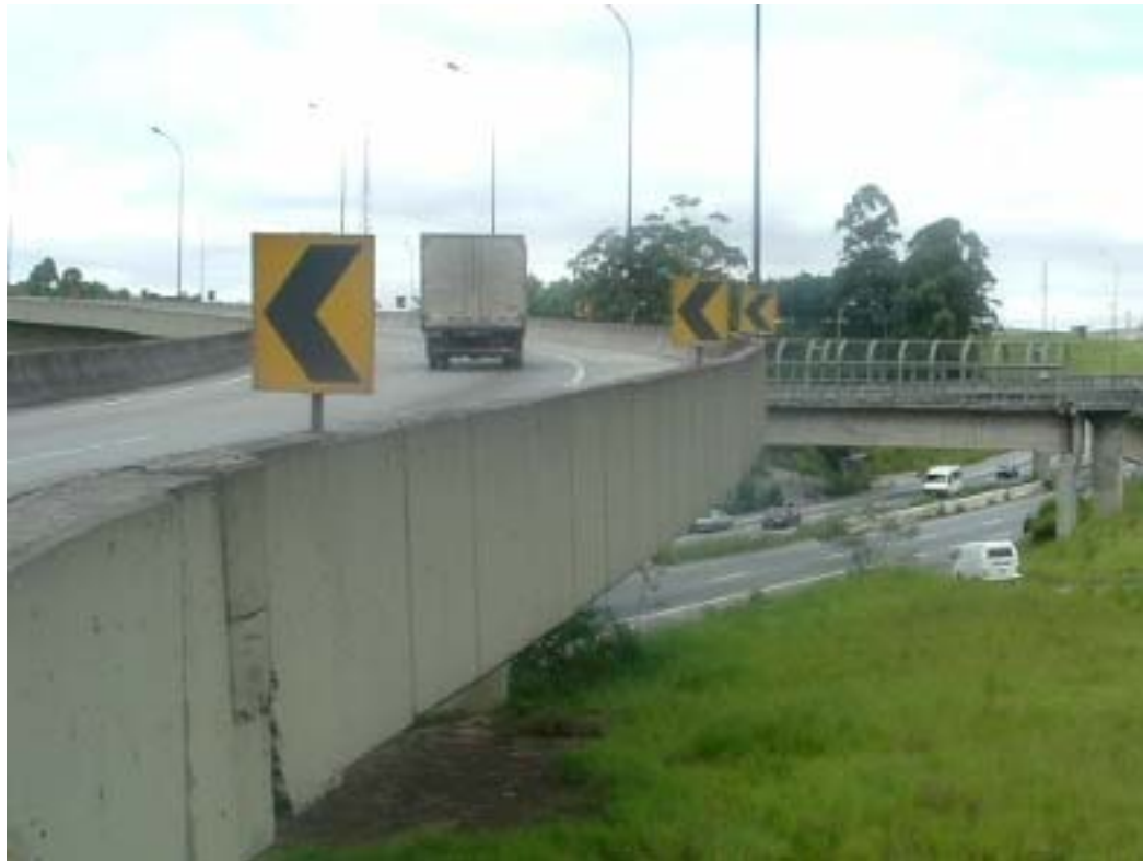
O.A.E. do acesso ao Rodoanel pela Rod. Régis Bittencourt (sentido Taboão da Serra)
