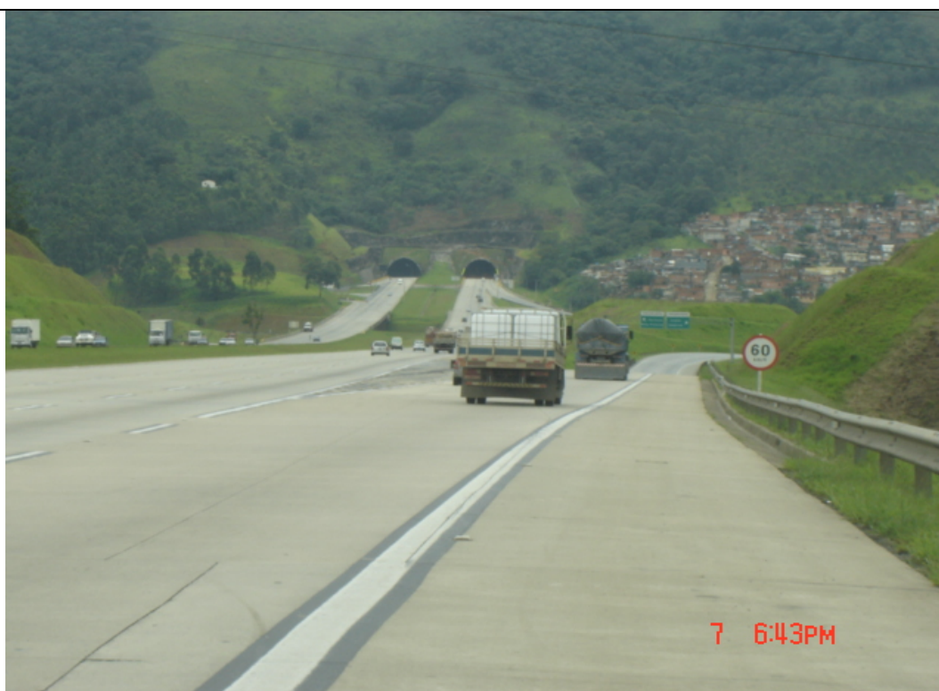
Interseção Anhanguera e túneis TE-1 e TI-1 ao fundo (sentido Embu) – km 5,9
