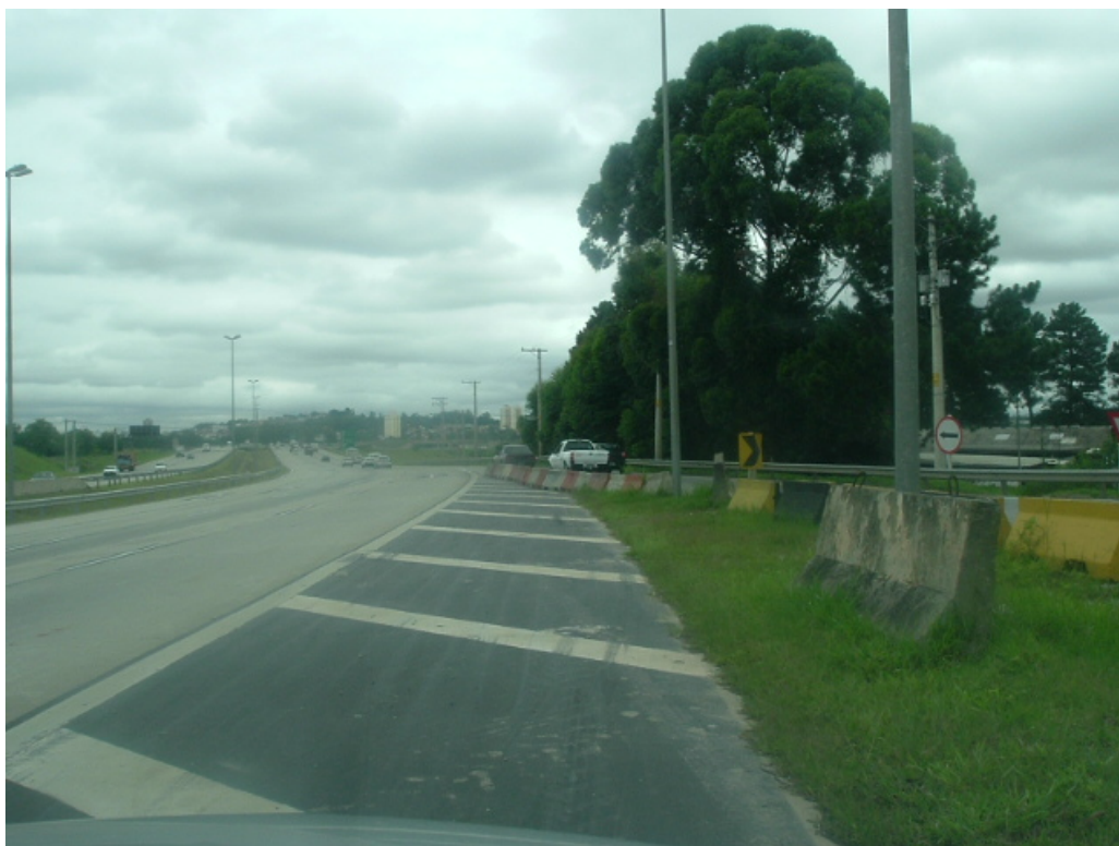
Alça de acesso da Rod. Castello Branco ao Rodoanel (pista externa) – km 14,5
