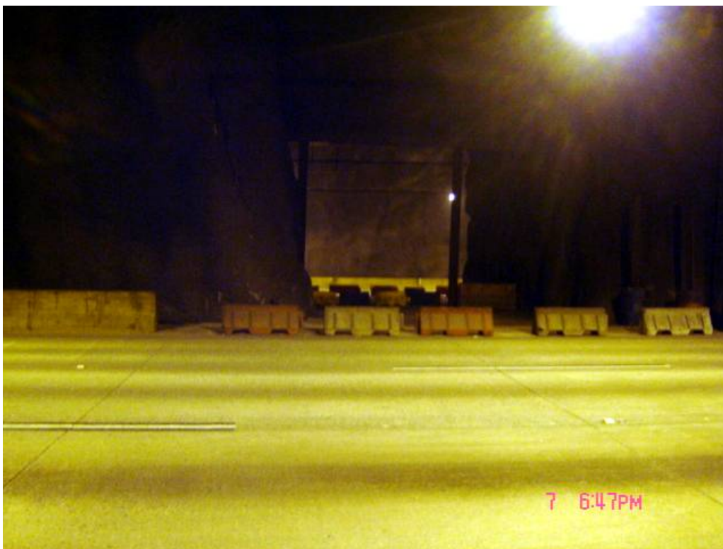
Vista de um dos três retornos operacionais da parte interna do túnel TE-1 para TI-1
