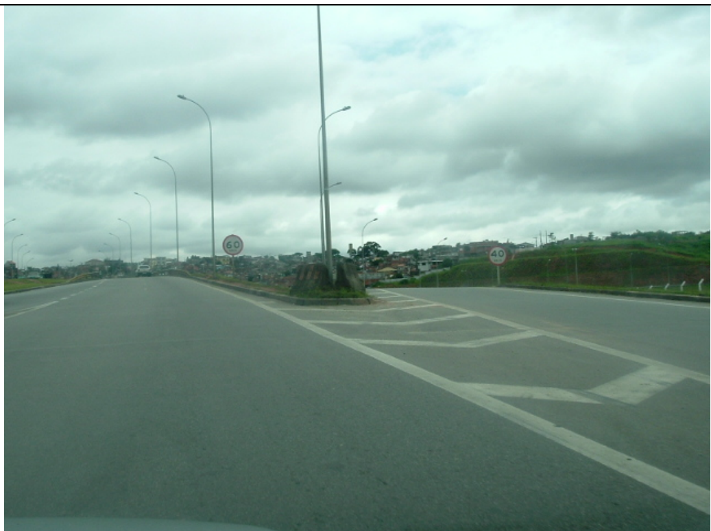
Alça de Carapicuíba para o Rodoanel (pista externa) à direita e para Osasco (esq.)
