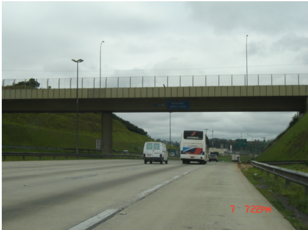
Passagem superior – km 23,5
