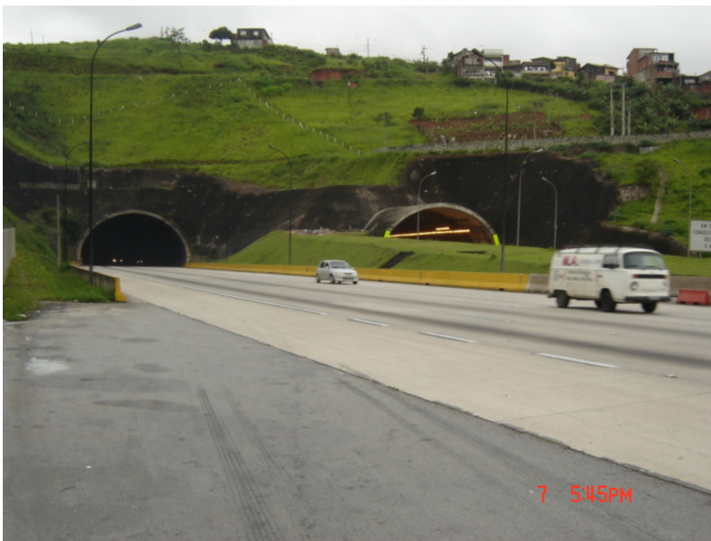
Vista do Portal dos túneis TE-2 e TI-2 (vista sentido Embu) - km 10,6
