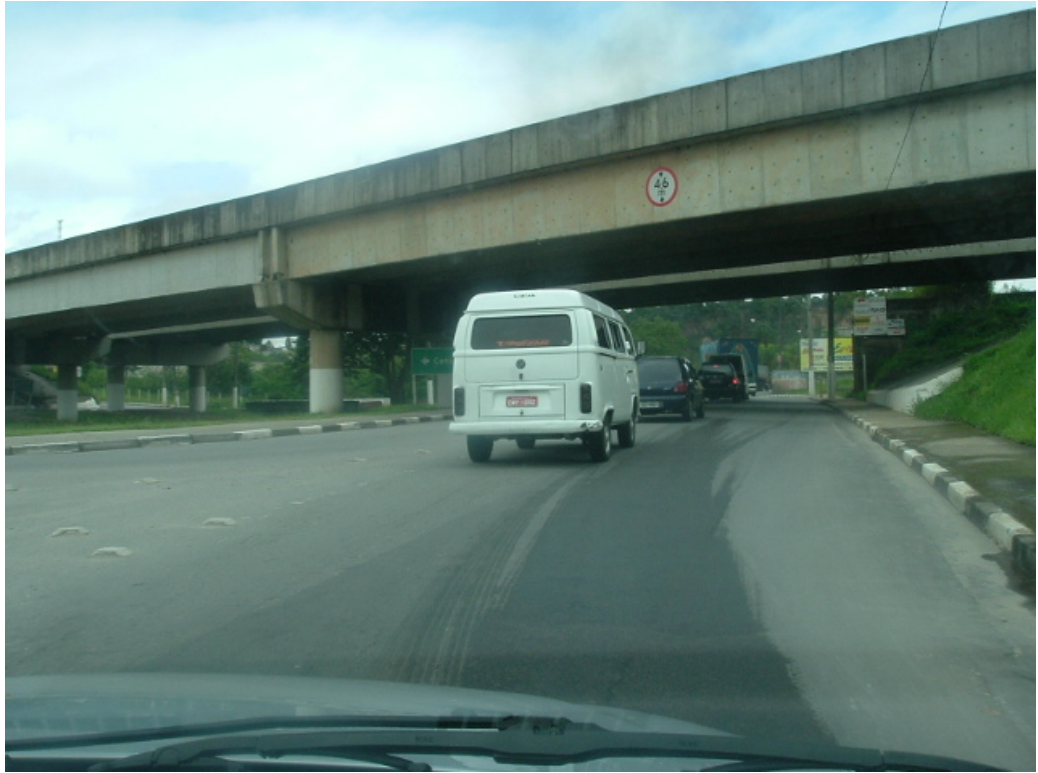
O.A.E. do retorno da Rod. Régis Bittencourt com acesso à Embu
