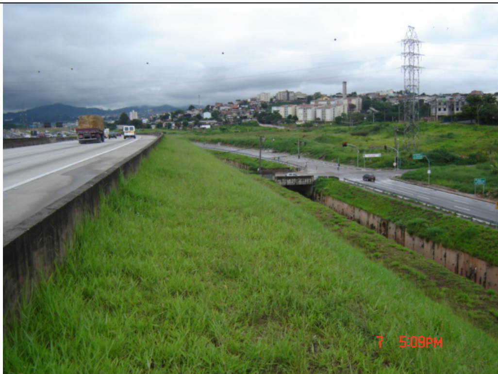
Passagem inferior e canalização do Córrego Carapicuíba (pista interna) – km 18,1
