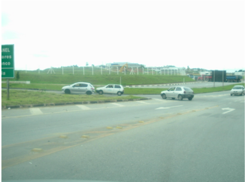
Acesso de Carapicuíba para a Interseção
