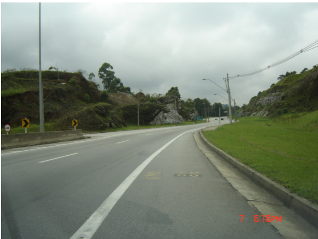
Alça do Rodoanel (p. interna) chegando na Av. R. Pereira de Magalhães
