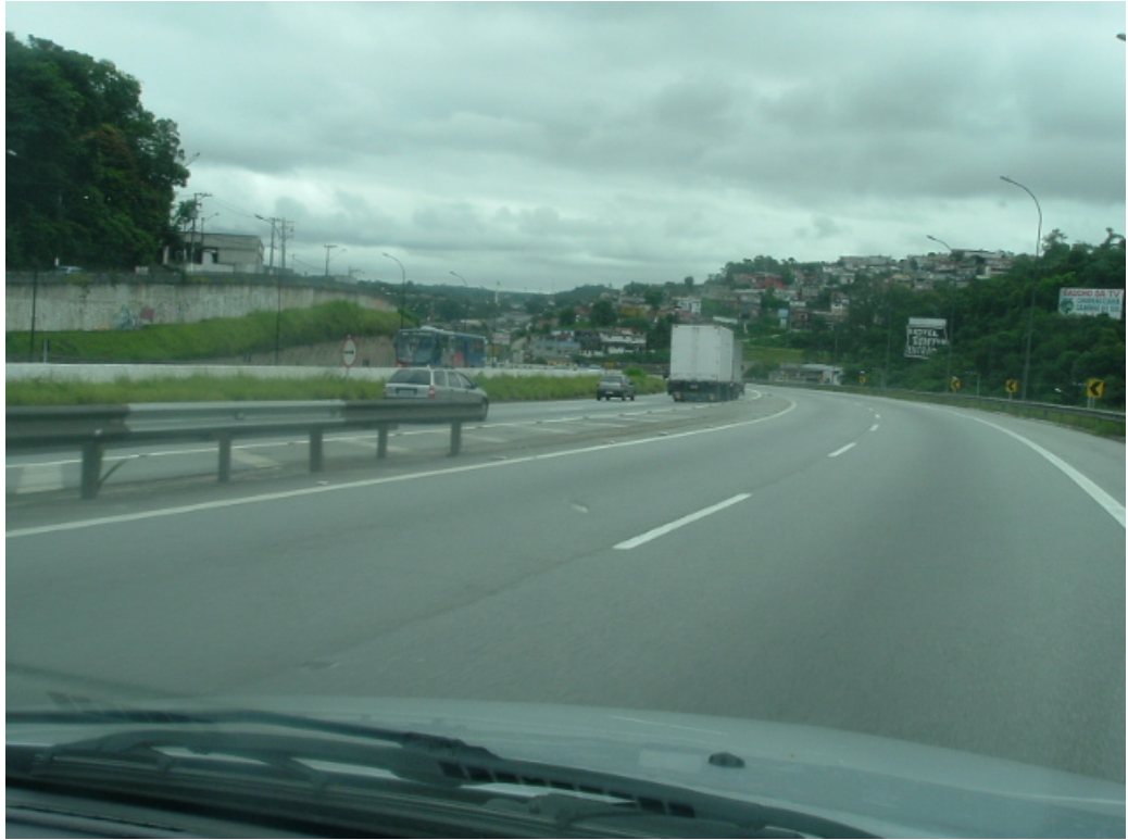
Acesso à Rod. Régis Bittencourt (sentido Embu)
