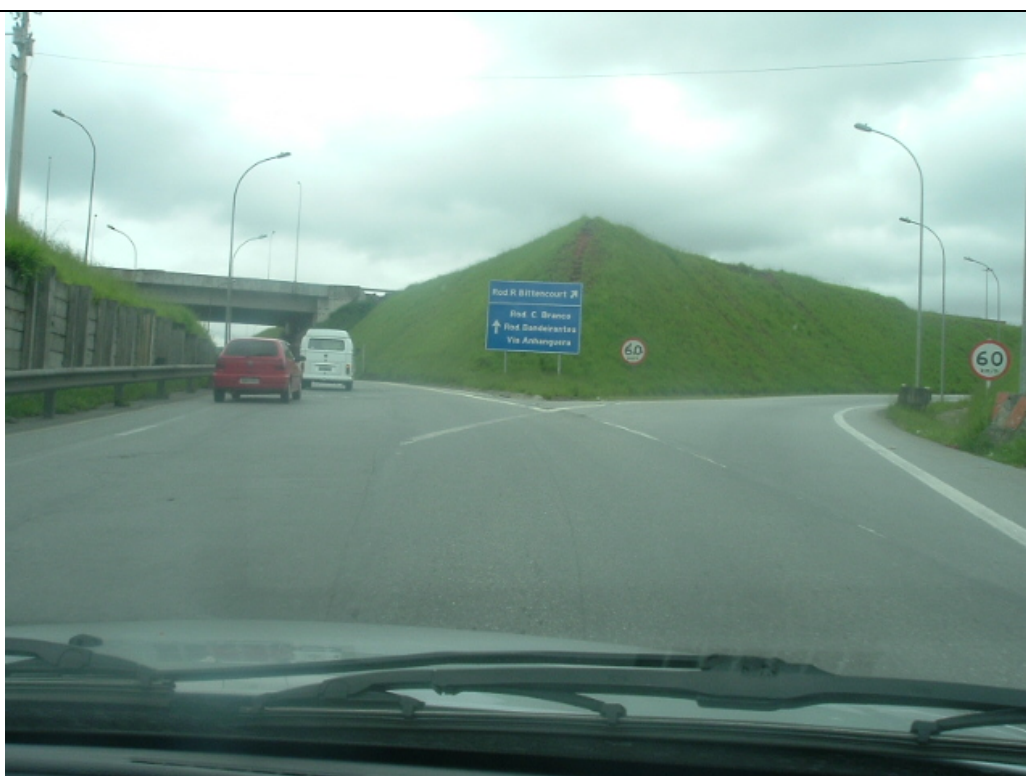
Alça para a pista externa do Rodoanel (dir.) e para pista interna (esq.)
