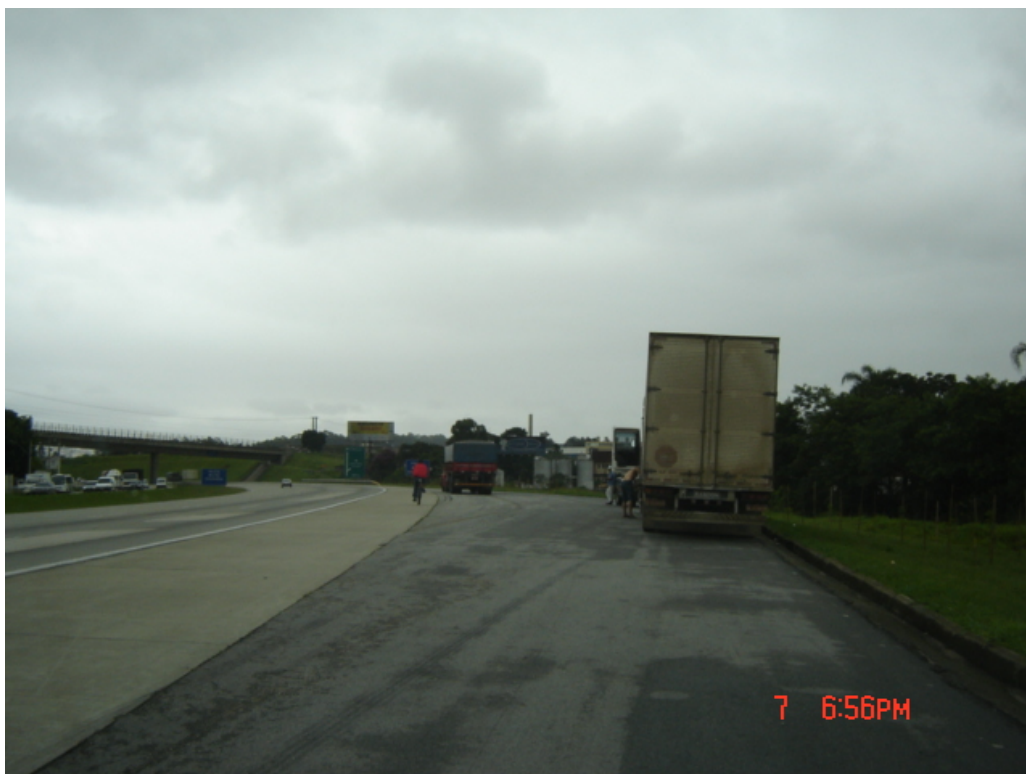
Área de operações da P.M.R.V. (pista externa) – km 13,4
