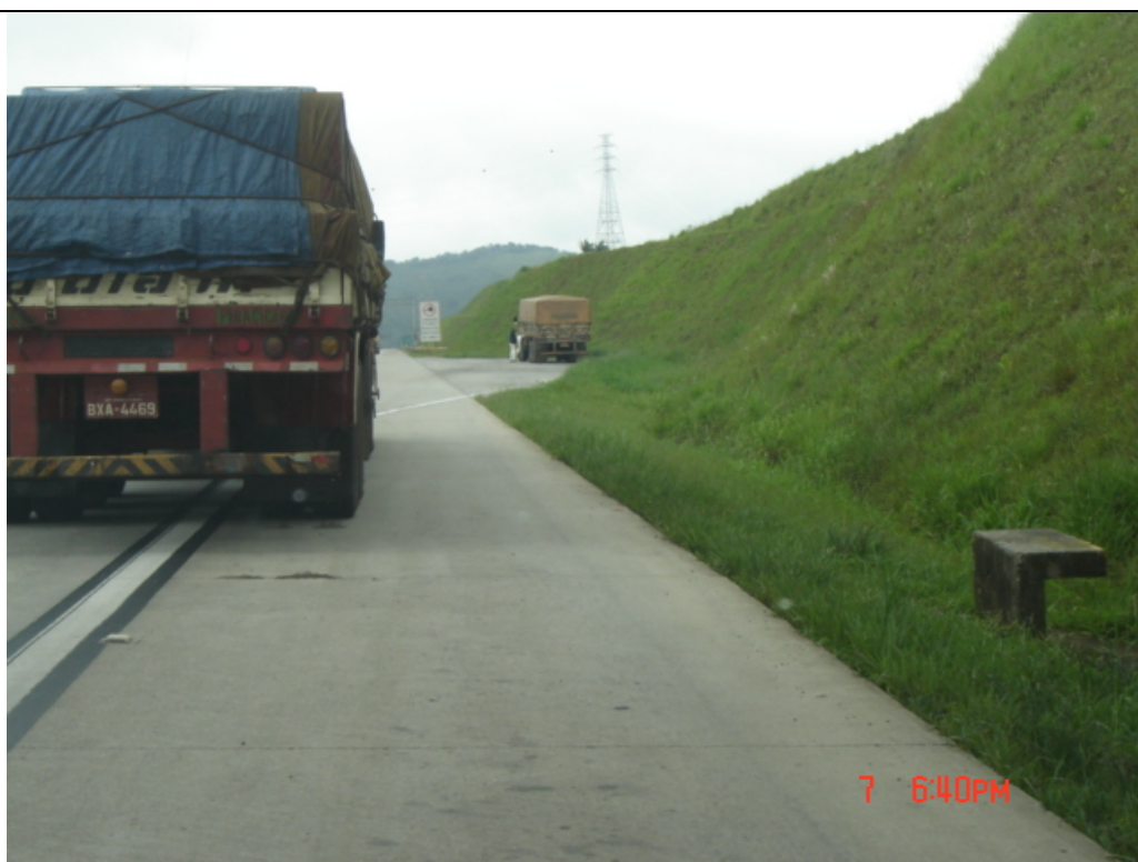
Área de descanso (pista externa) – km 4,6
