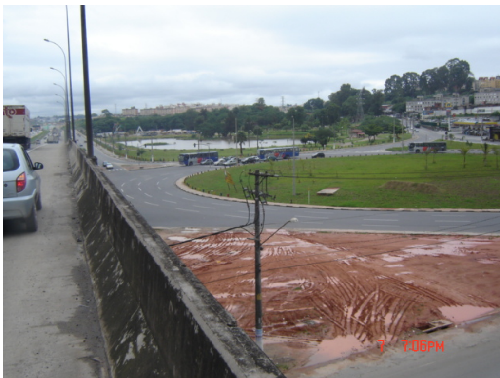
Travessia sobre CPTM e Av dos Autonomistas (pista externa) – km 16,2
