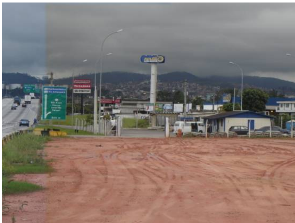
Instalações da DERSA (pista interna) – km 16,6
