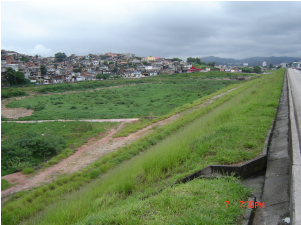
Área da Bacia de Detenção 1 (pista externa) – km 18,5
