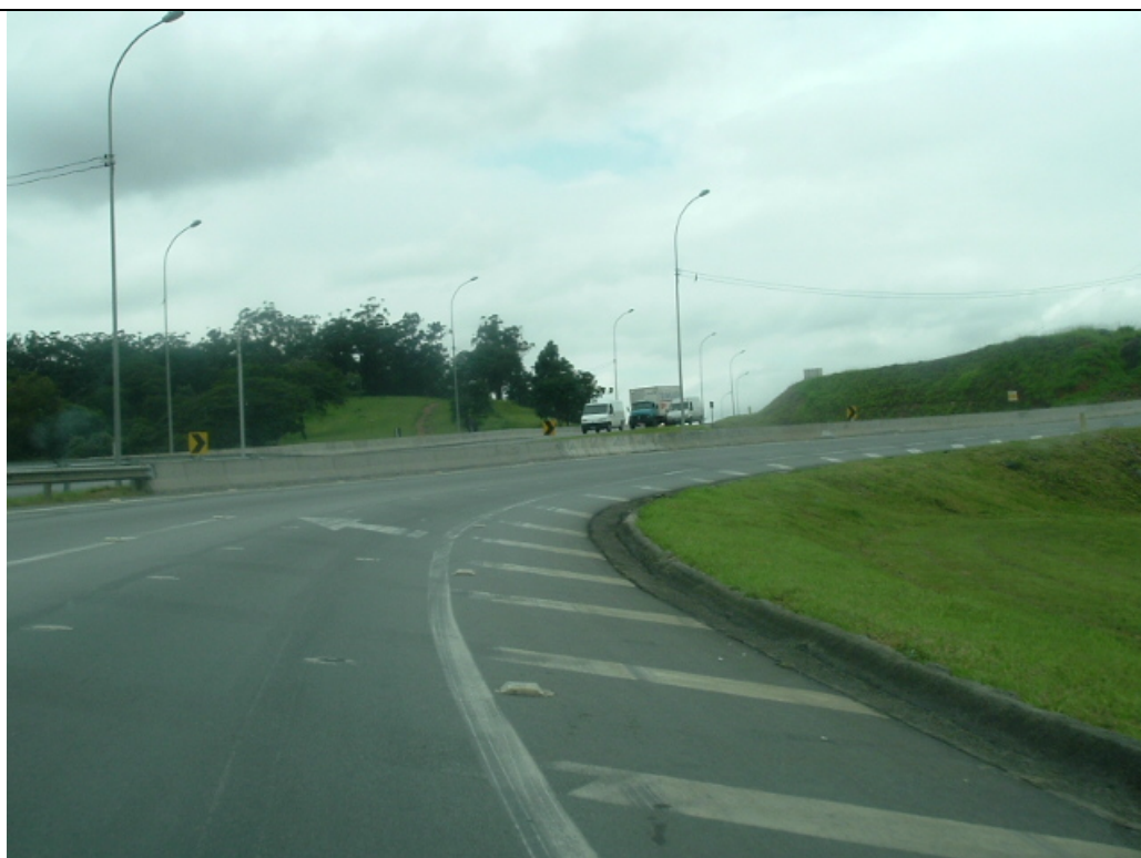
Chegada das alças na Rod. Castello Branco (sentido interior)
