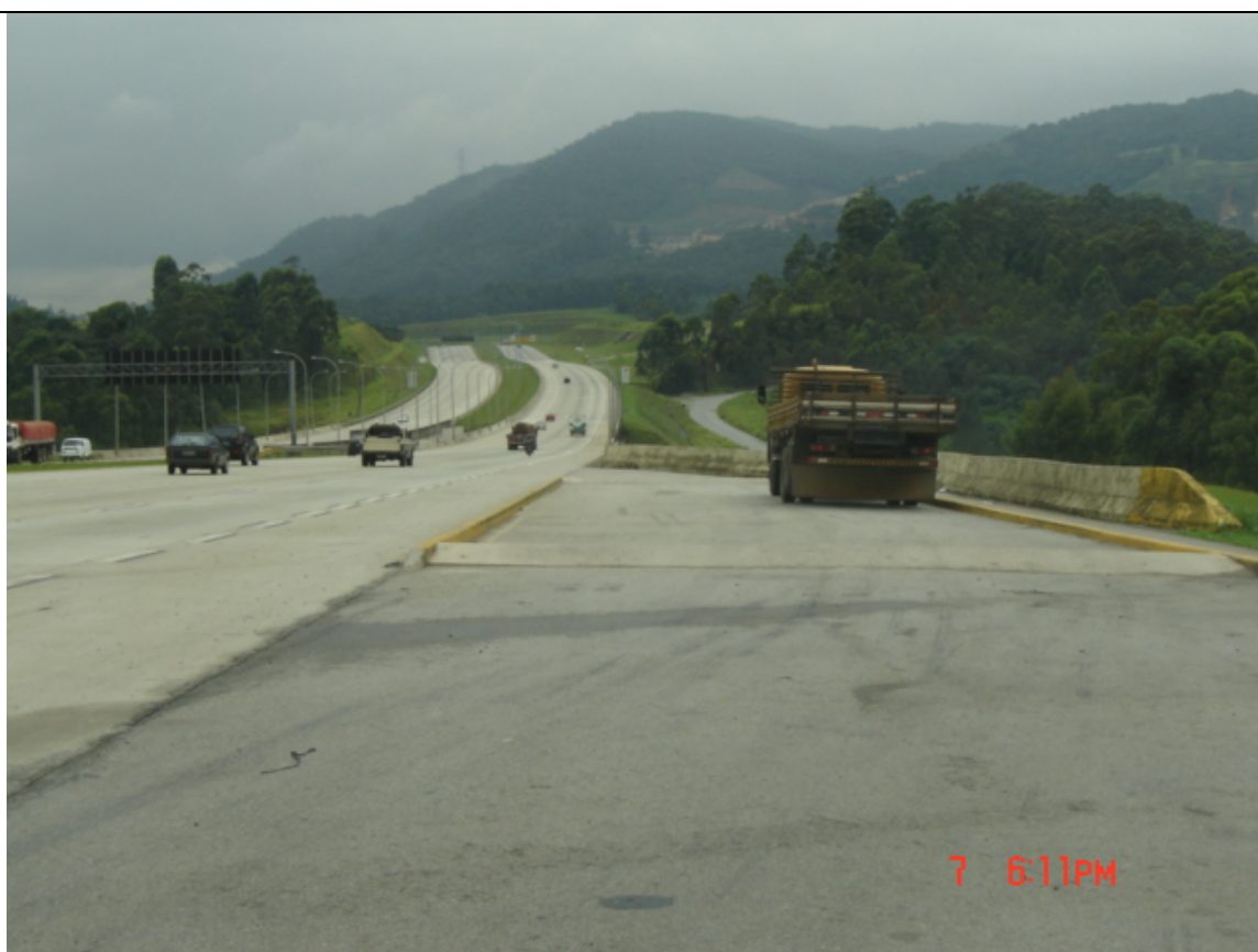
Área para Balança (pista interna) – km 1,4
