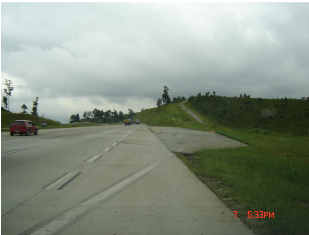
Área para Balança (pista externa) – km 1,4
