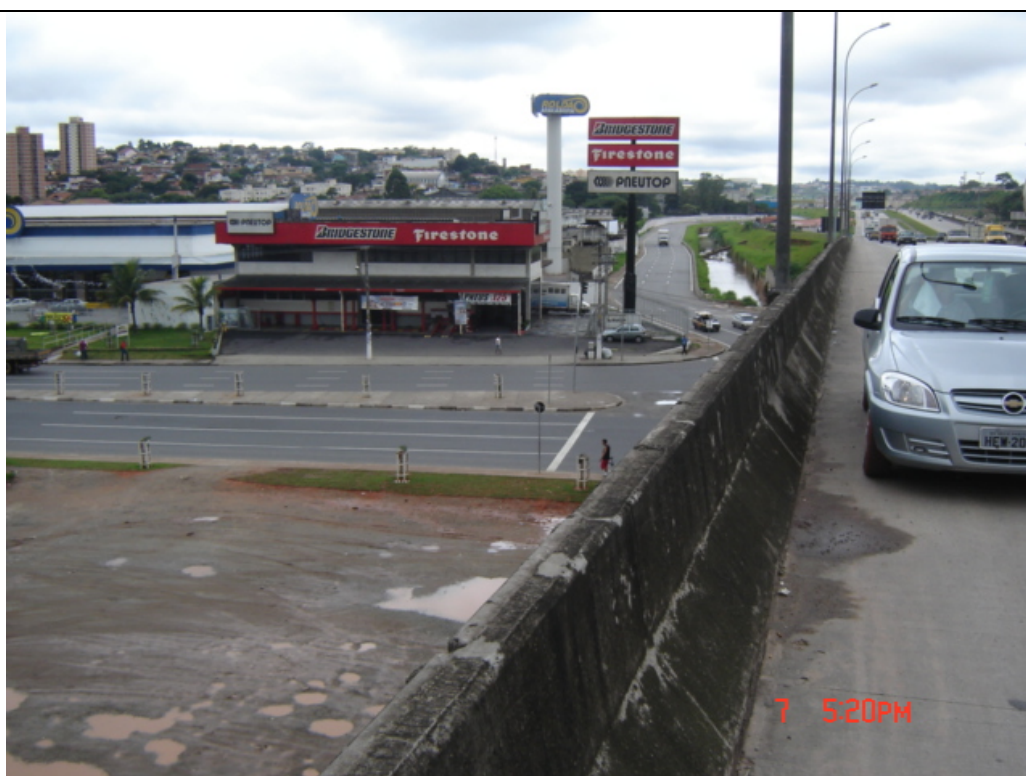
Travessia sobre CPTM e Av. dos Autonomistas (pista interna) – km 16,2
