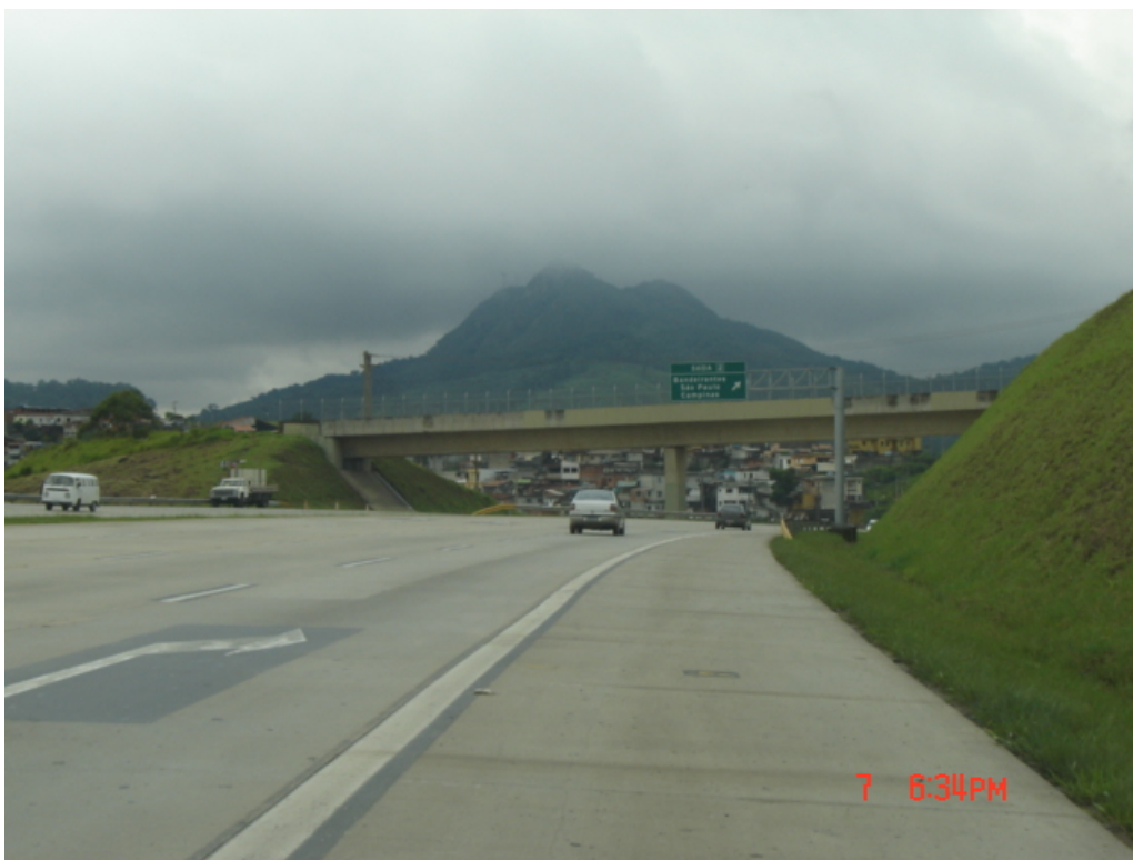
Passagem superior – km 2,6
