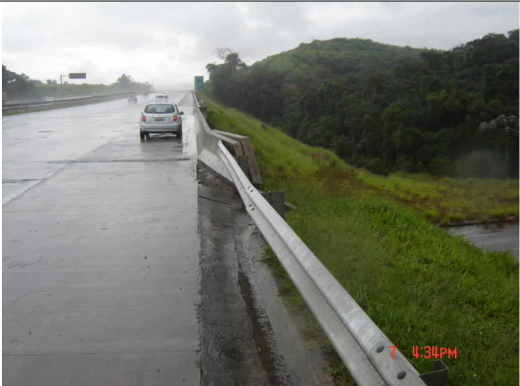
Passagem inferior (pista interna) – km 25,8
