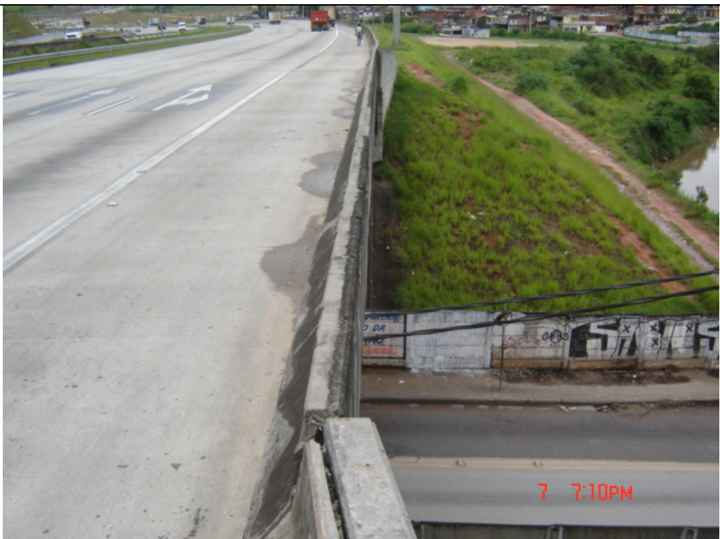
Passagem inferior (pista externa) – km 18,8
