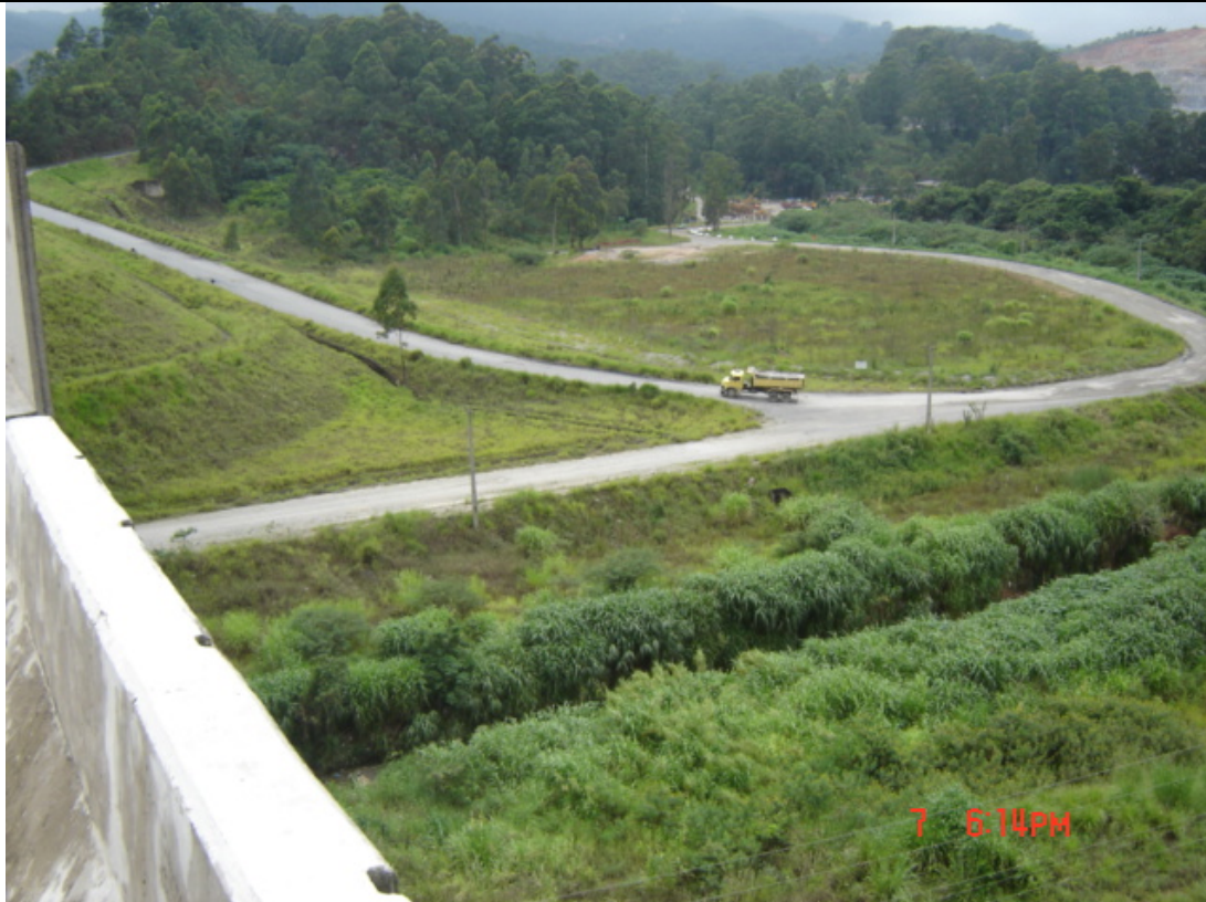
Passagem inferior de ferrovia, riacho e estrada de acesso à Jazida (pista interna) – km 1,0
