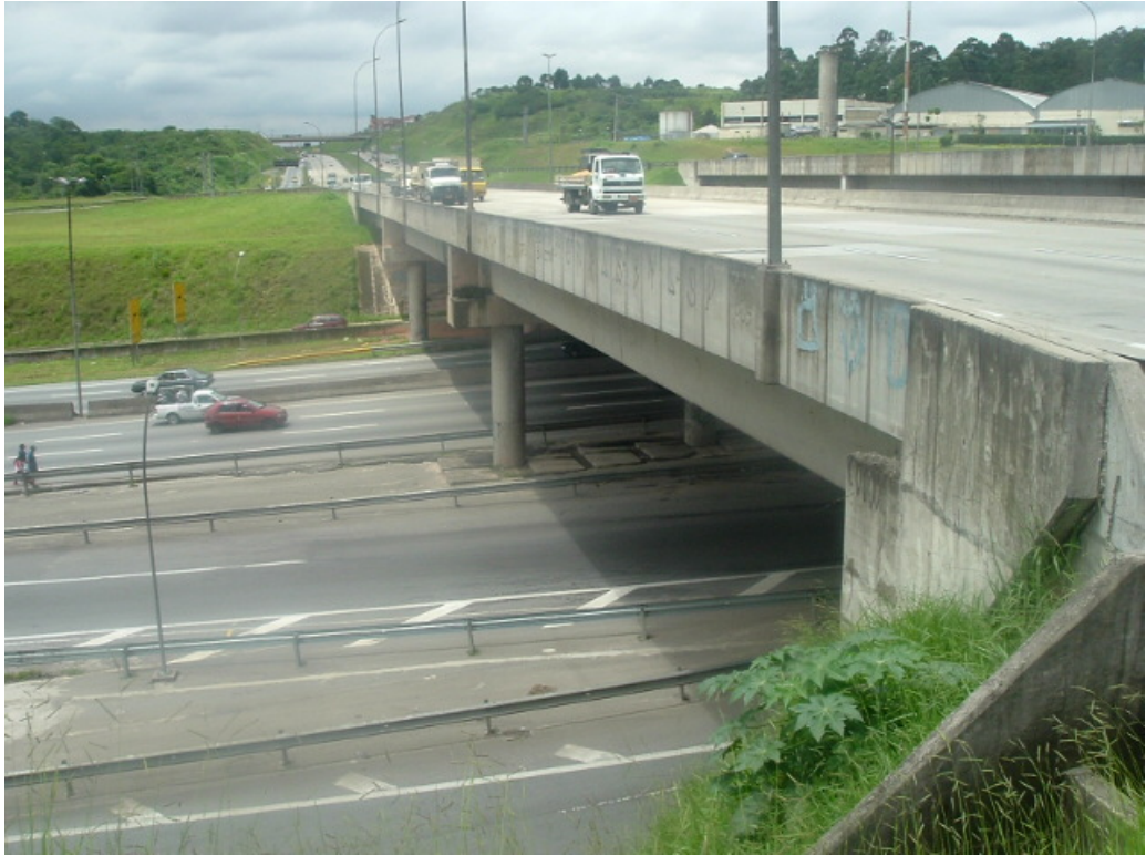
Travessia do Rodoanel sobre a Rod. Raposo Tavares (pista externa) – km 24,4
