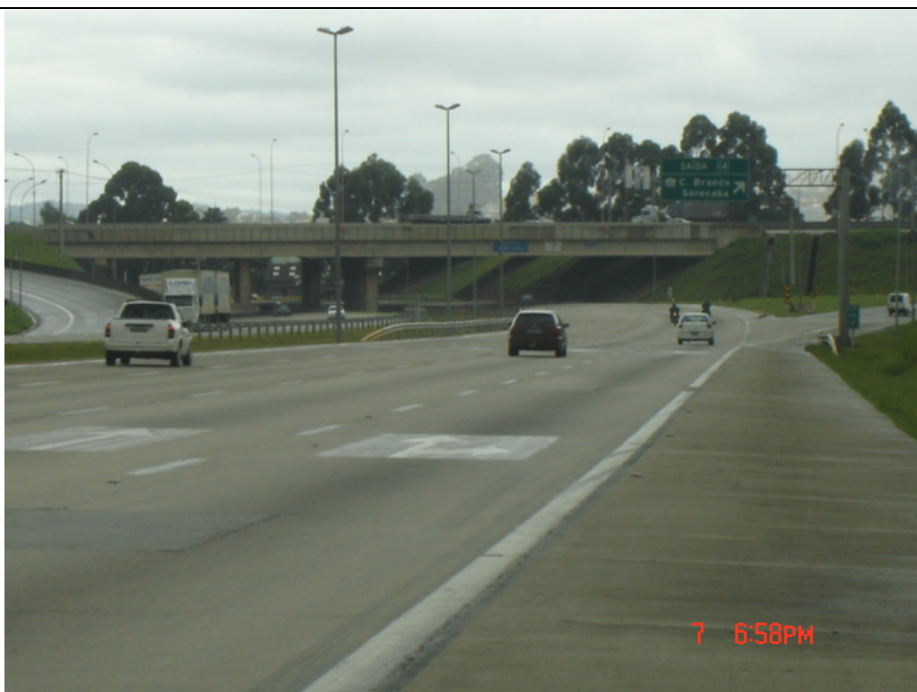
Interseção Castello Branco – Travessia sob a rodovia e alças de acesso – km 14,4
