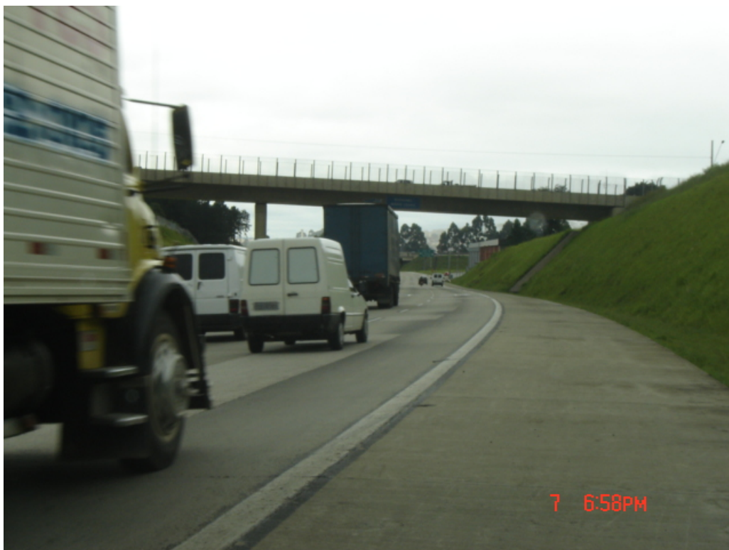
Passagem superior – km 13,8
