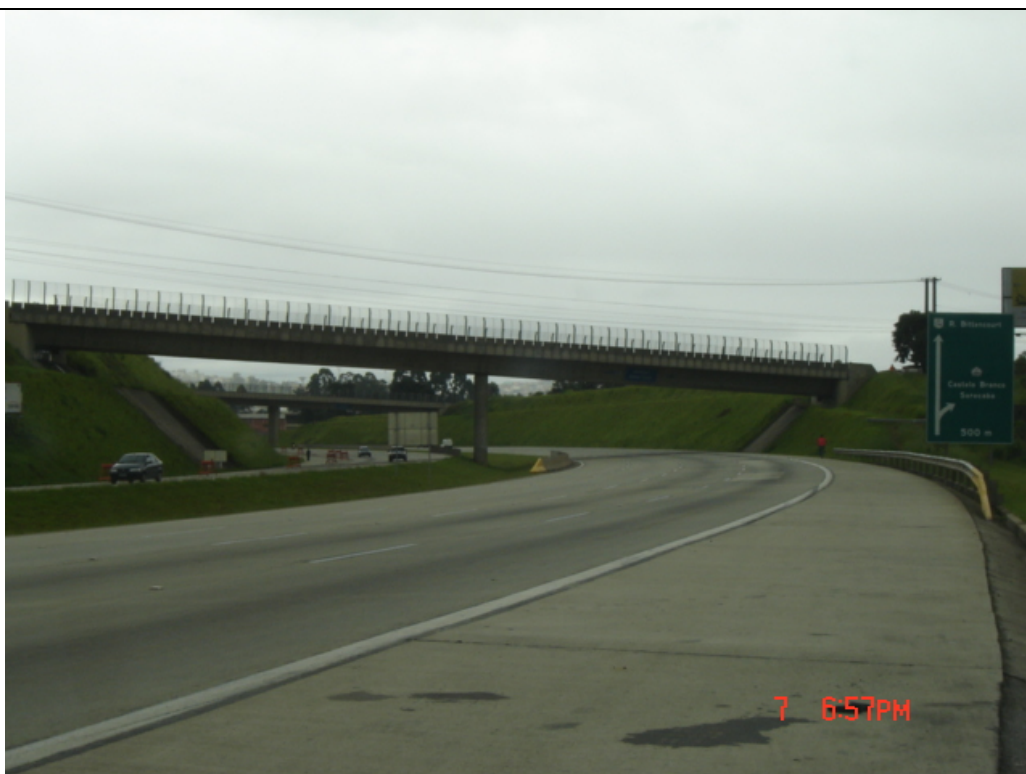
Passagem superior – km 13,5
