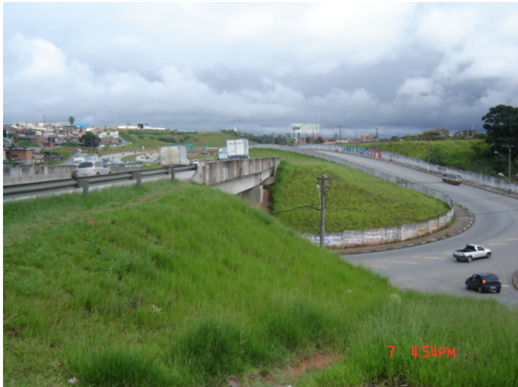
Passagem inferior (pista interna) – km 21,7
