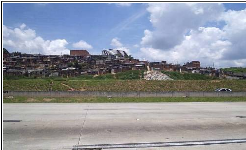
Foto 01 - NU-001 - Ocupação irregular da faixa de domínio por favela Erosão e lixo avança no talude
