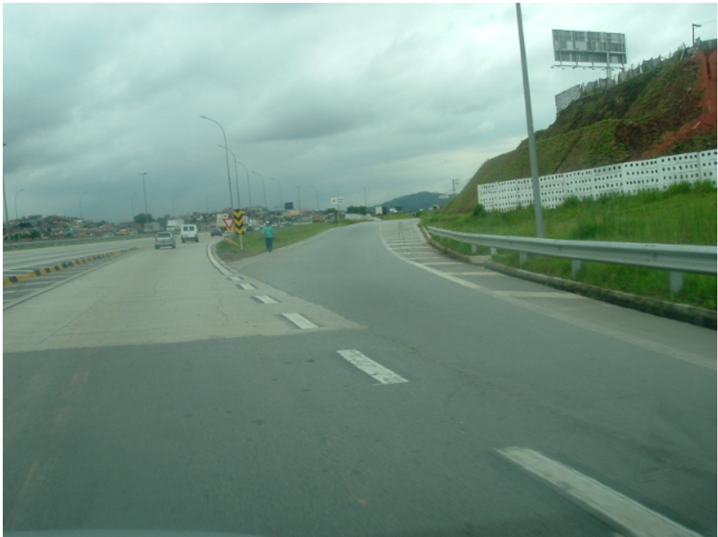
Acesso da alça para o Rodoanel (pista interna) à Marginal do córrego Carapicuíba (Osasco)
