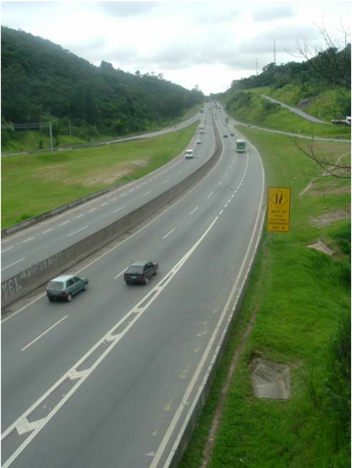
Vista da Rod. Anhanguera na interseção
