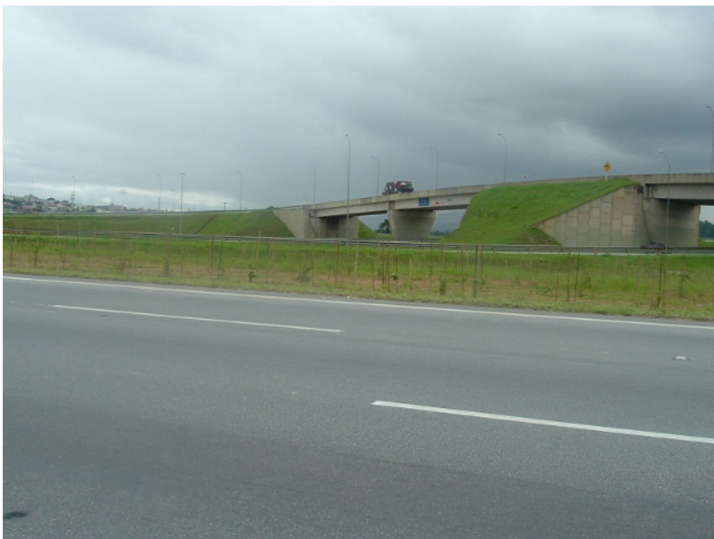
O.A.E. alça da Rod. Castello Branco (sentido interior ) para o Rodoanel (p. externa)
