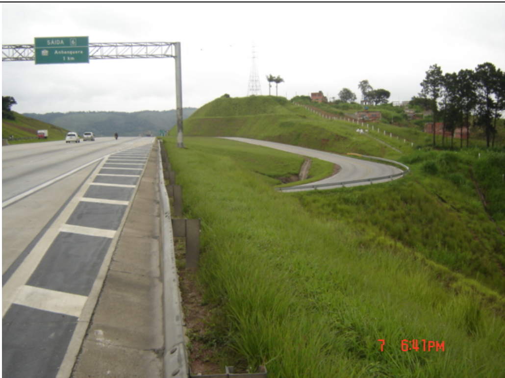
Passagem inferior (pista externa) – Retorno – km 4,9
