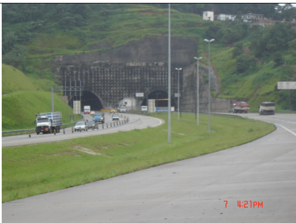
Vista do Portal dos túneis TE-3 e TI-3 (vista sentido Perus) - km 28,8
