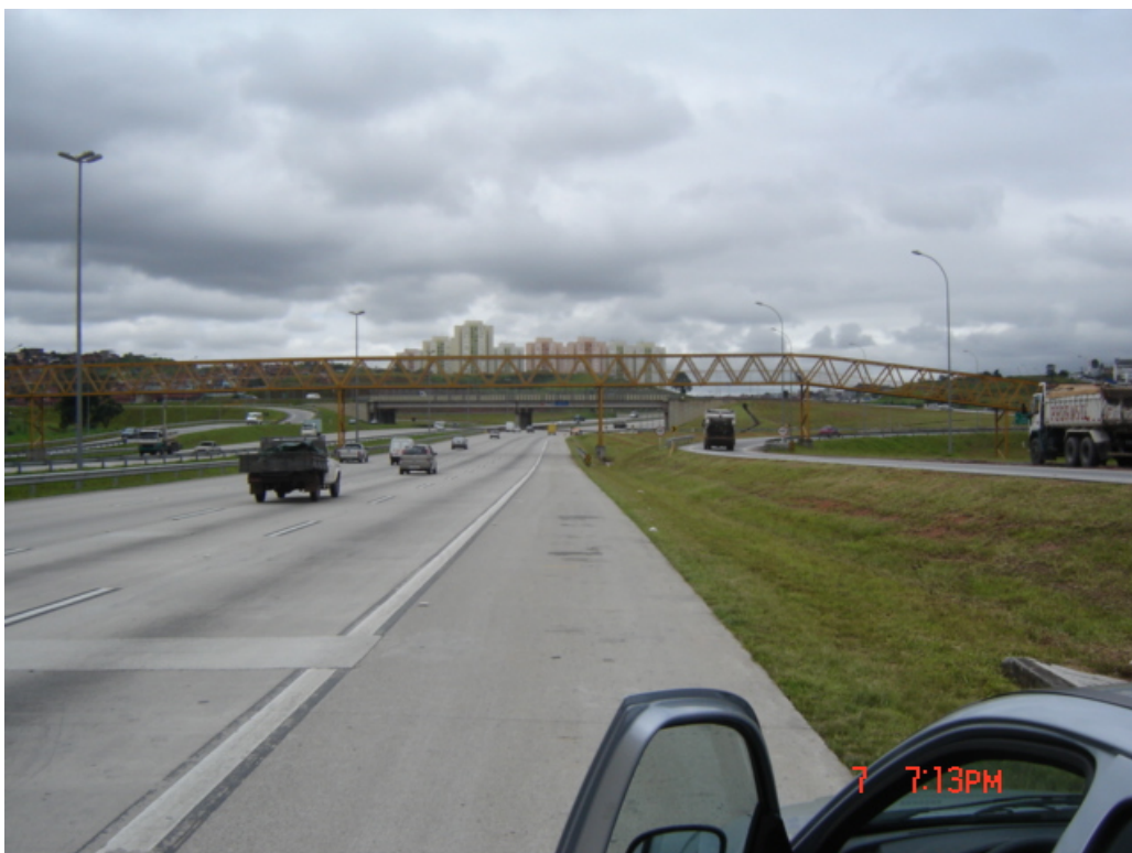
Vista da Interseção Padroeira e passarela metálica (vista sentido Embu) – km 19,7
