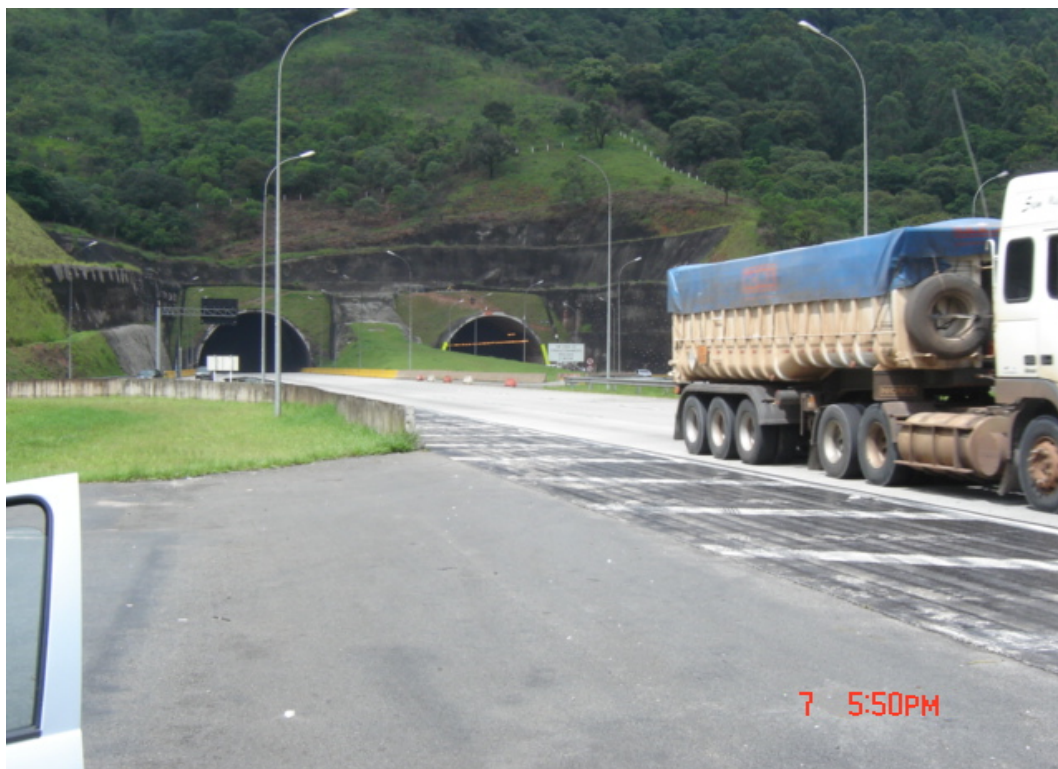
Portal dos túneis TE-1 e TI-1 (vista sentido Embu) - km 7,4
