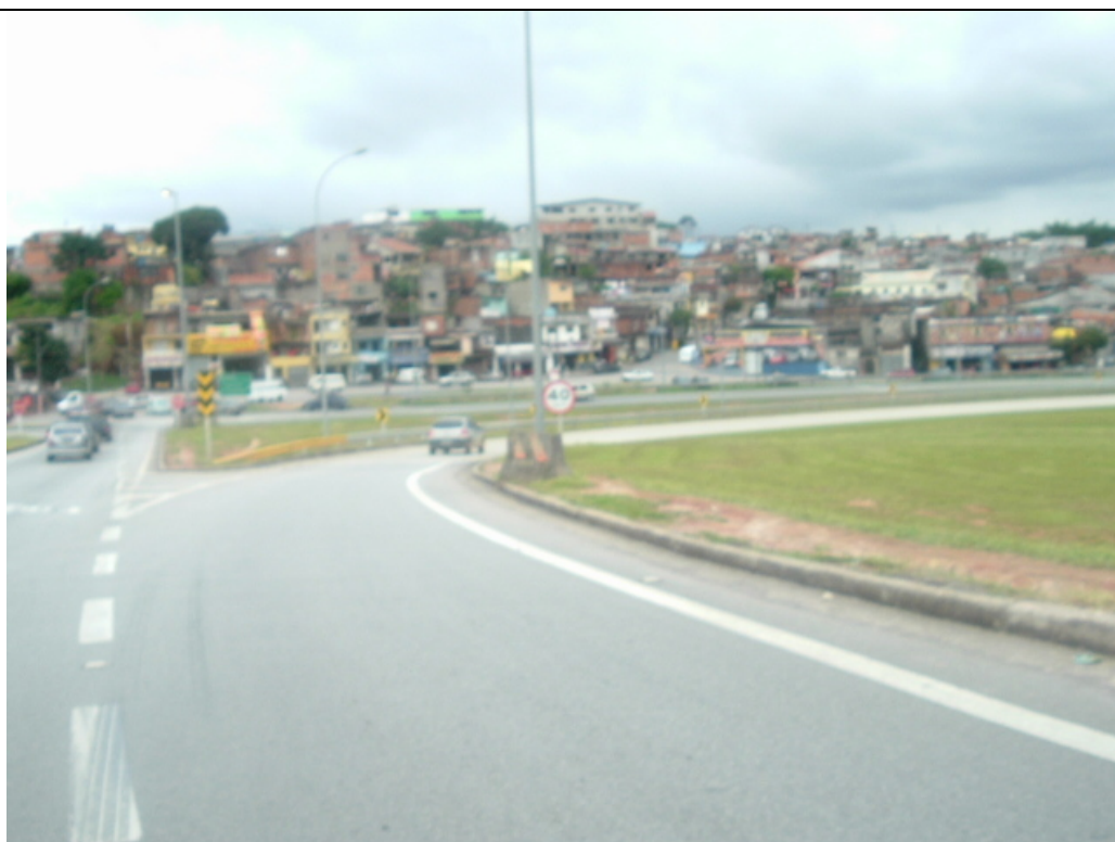
Acesso para o Rodoanel (pista externa) à esquerda e para Carapicuíba (dir.)
