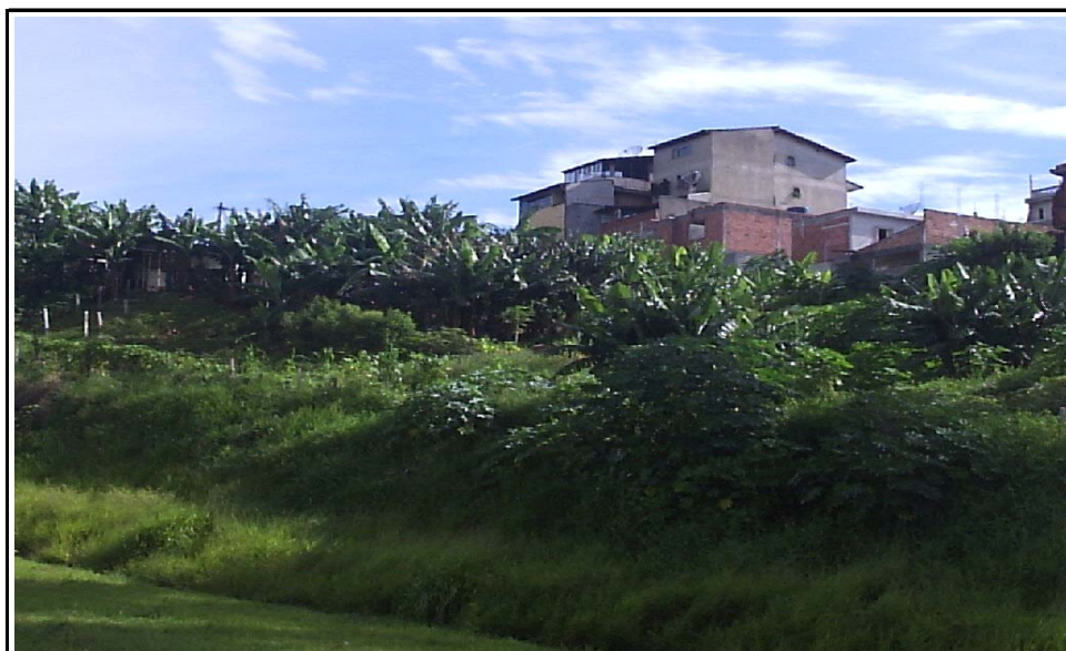
Foto 02 - NU-003 - Ocupação irregular da faixa de domínio Criação de animais no talude
