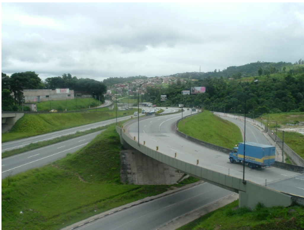
Vista da O.A.E. do acesso à Rod. Régis Bittencourt (sentido Embu) e marginal
