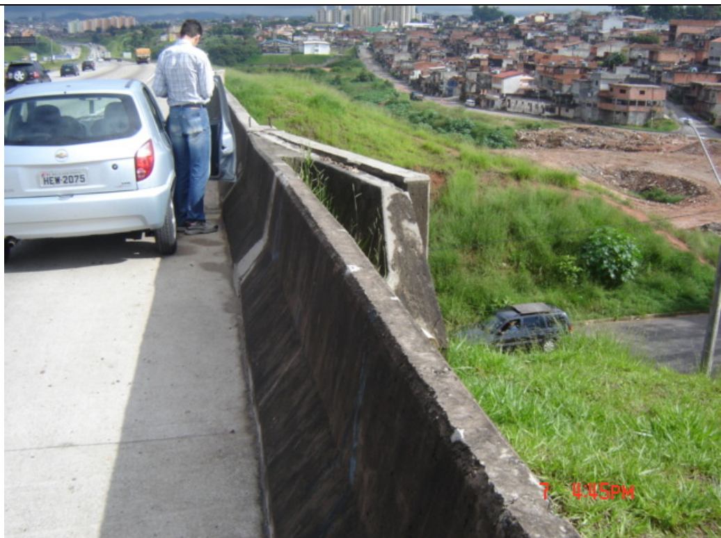
Passagem inferior (pista interna) – km 22,9
