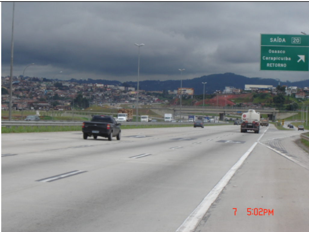
Vista da interseção Padroeira (vista sentido Perus) – km 19,7
