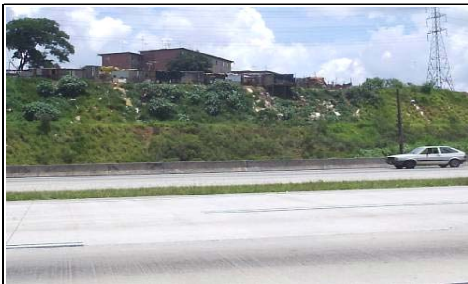
Foto 02 - NU-002 - Ocupação irregular da faixa de domínio por favela Erosão e lixo avança no talude
