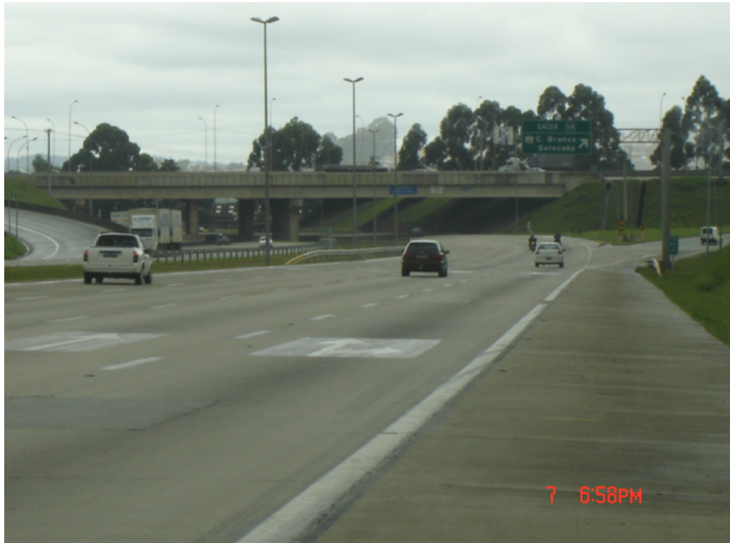
Vista da O.A.E. da Rod. Castello Branco sobre o Rodoanel e alças (pista externa)
