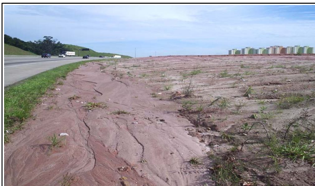
Foto 2 - AT-003 - Erosão com ravinamento devido ausência de canaletas de drenagem Assoreamento de córrego e de várzea - ausência de cobertura vegetal
