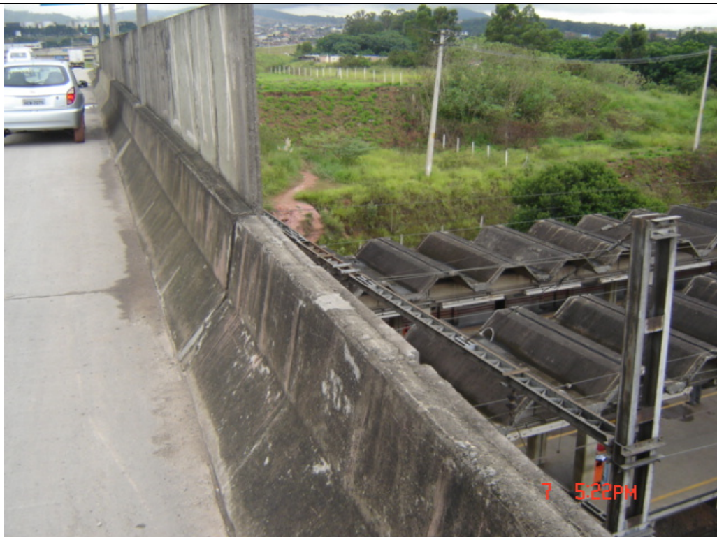
Travessia sobre CPTM e Av. dos Autonomistas (pista interna) – km 16,1
