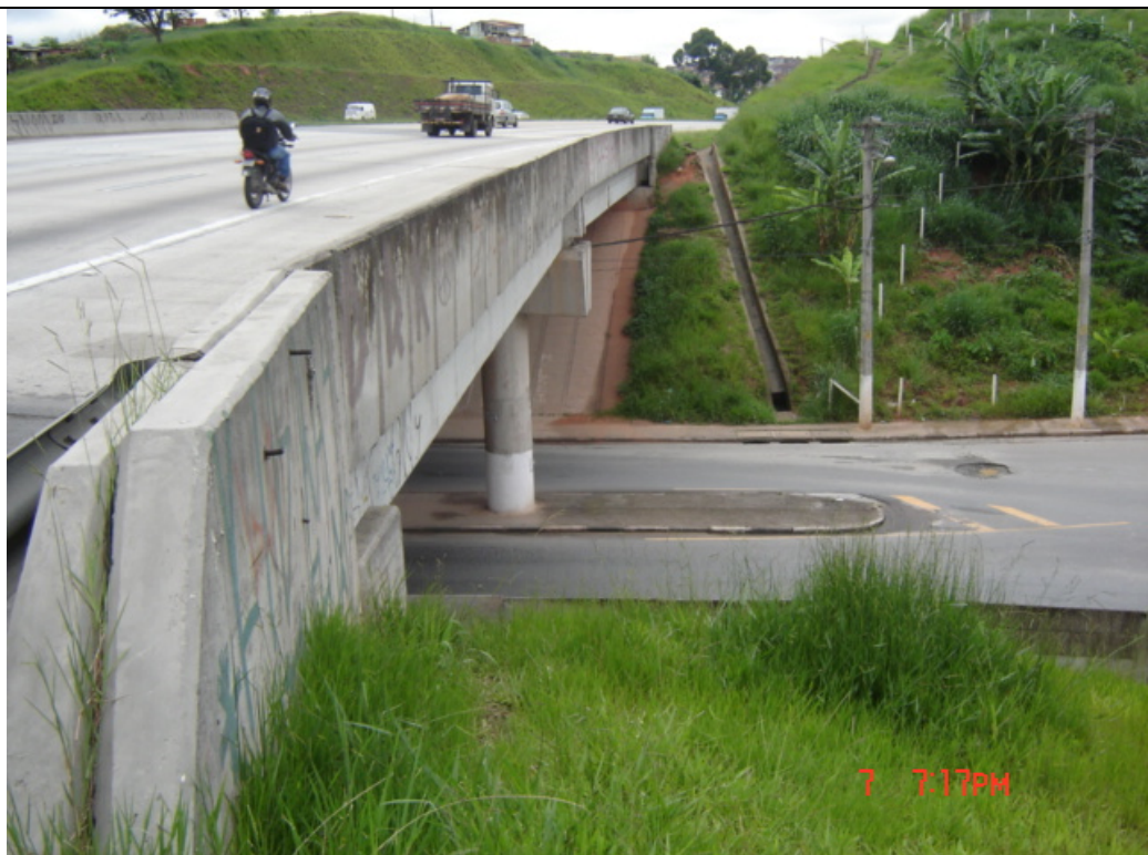
Passagem inferior (pista externa) – km 21,7
