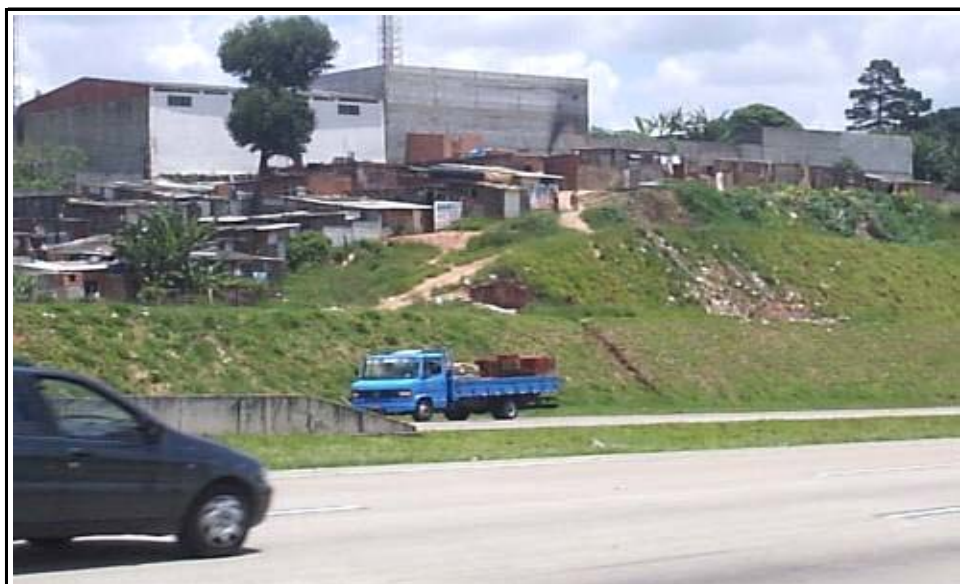
Foto 02 - NU-001 - Ocupação irregular da faixa de domínio por favela Erosão e lixo avança no talude
