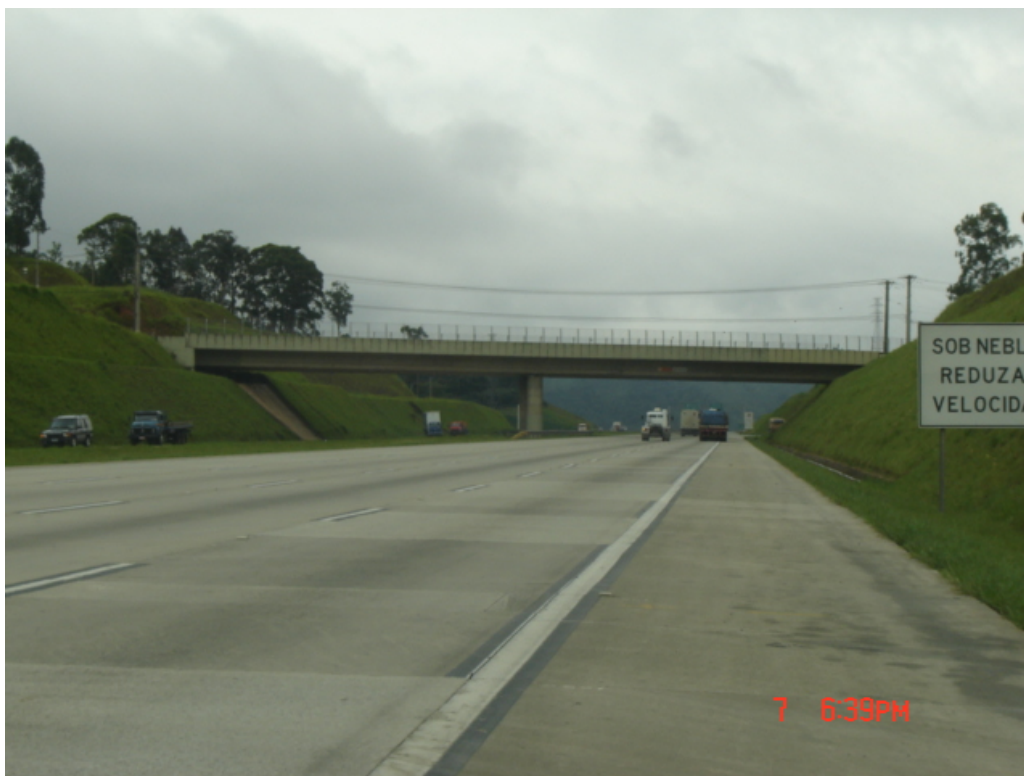
Passagem superior – km 4,5
