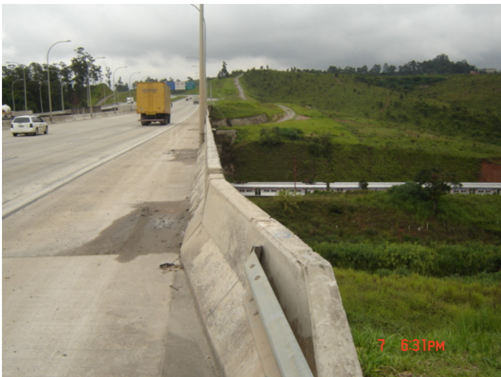
Passagem inferior de ferrovia, riacho e estrada de acesso à Jazida (pista externa) – km 1,0
