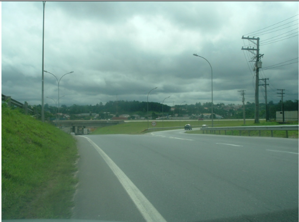
Acessos para a pista externa do Rodoanel (esq.) e pista interna (dir.)
