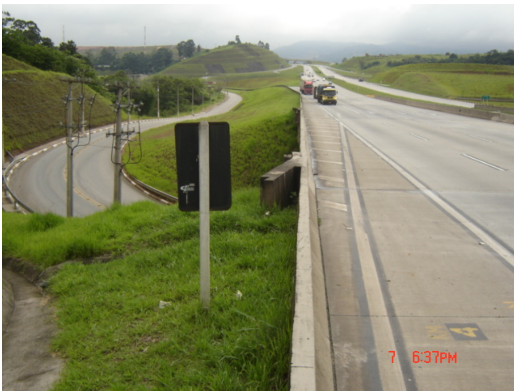
Passagem Inferior de via local (pista externa) – km 4,0
