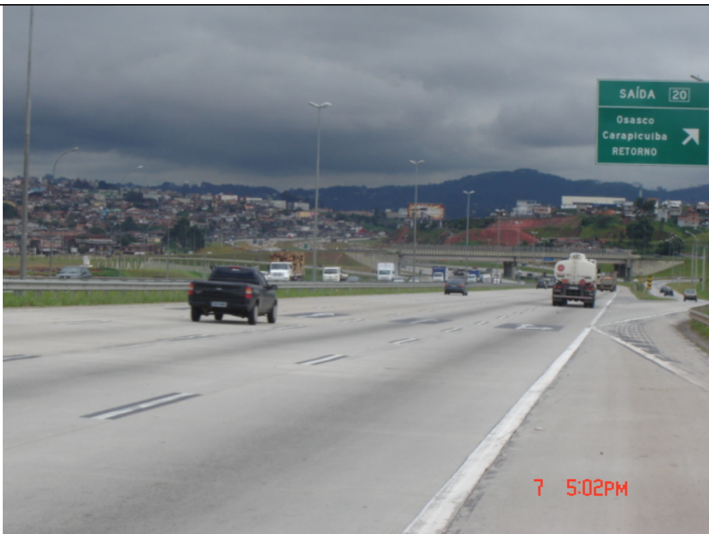
Vista das O.A.E. da Interseção Padroeira (pista interna) e alça de acesso
