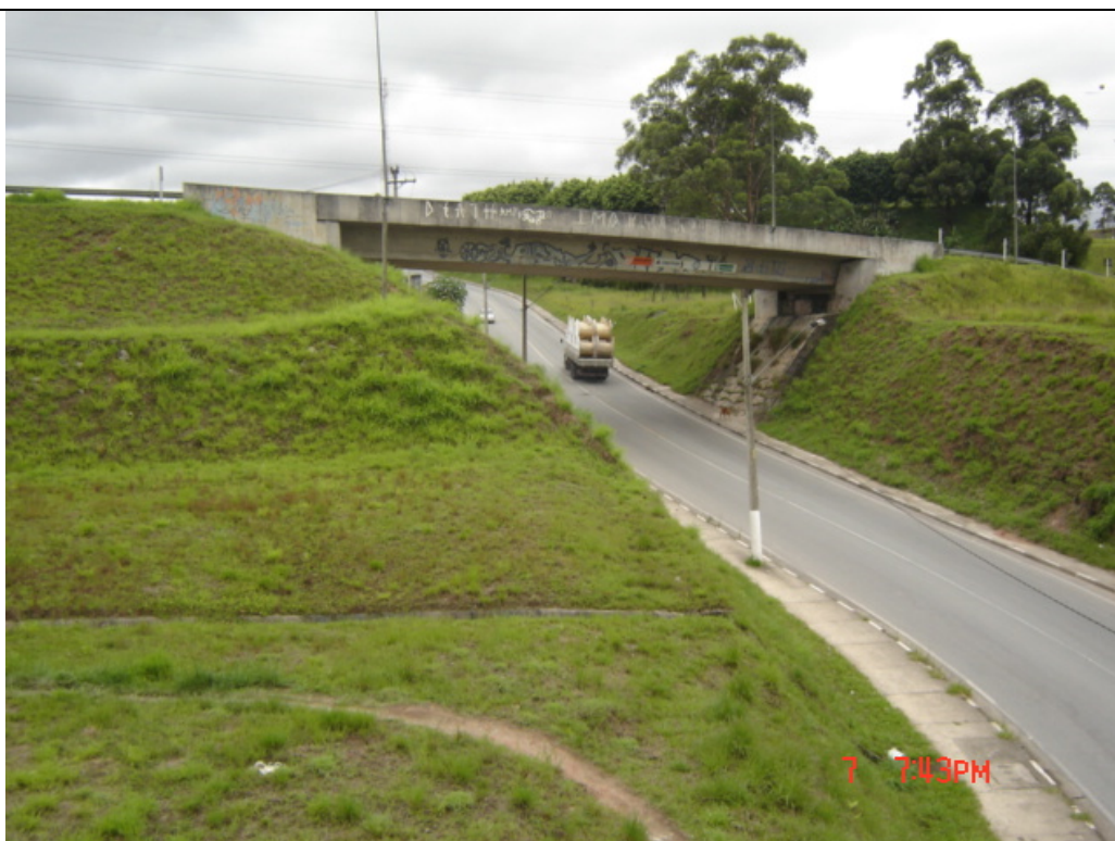
O.A.E. do acesso da Rod. Régis Bittencourt (sentido Embu) ao Rodoanel e marginal
