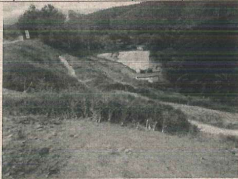
Fotos 1.5 e 1.6. Estabilizar os taludes e redimensionar o sistema de drenagem definitivo de modo a evitar o assoreamento da lagoa em propriedade limdeira (Km 25).
