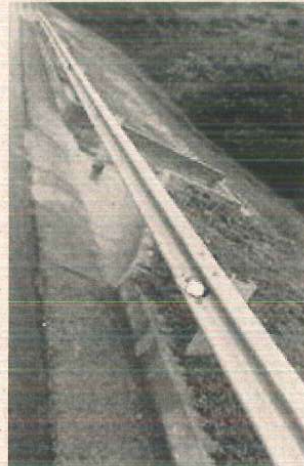
Foi realizado o direcionamento do fluxo de águas pluviais para caixa de contenção de produtos perigosos.
