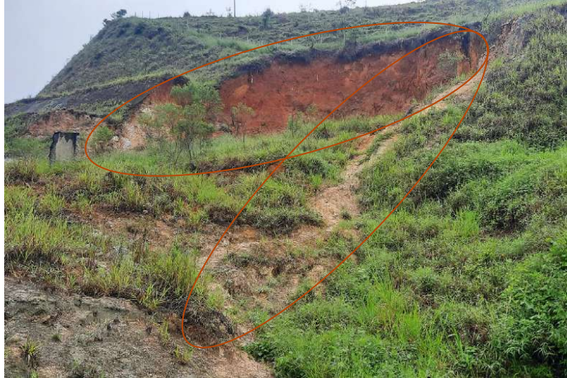
Figura 51: Talude 13 - Rompimento em Solo.
