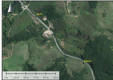
Figura 48: Talude 13- Localização do Talude 13 - km 52 mostrando o local de ruptura.
