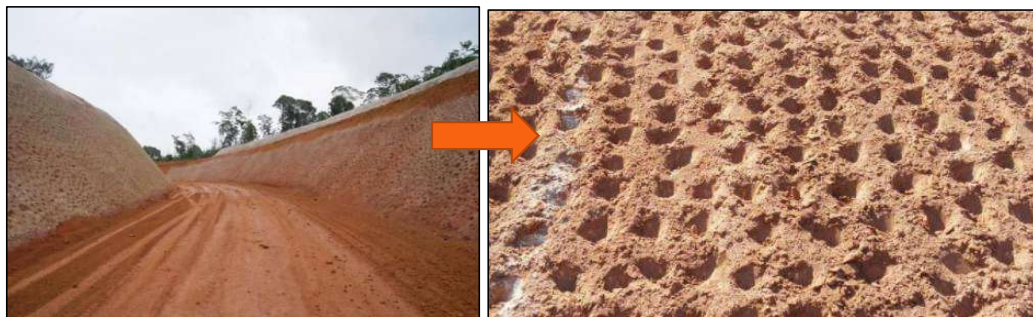
Figura 67: Taludes Ambientais - Exemplo de hidrossemeadura realizada em talude.
