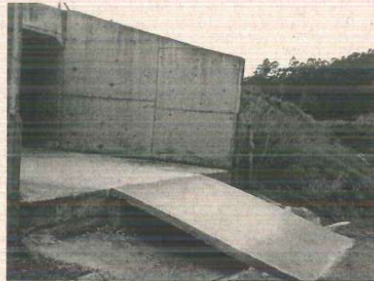
Foi implantada uma rampa de concreto no emboque da passagem de fauna com finalidade de eliminar o desnível existente no local.
