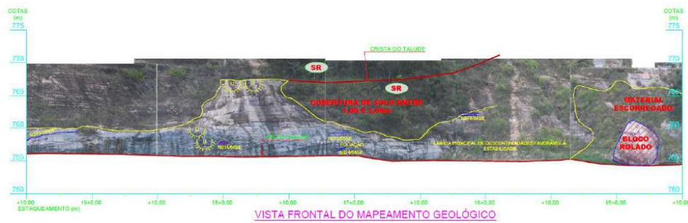
Figura 37: Talude 11 - Mapeamento Geológico.
