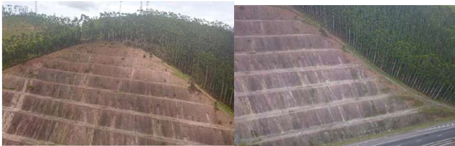
Figura 79: Talude 21 - Vista frontal e lateral.
