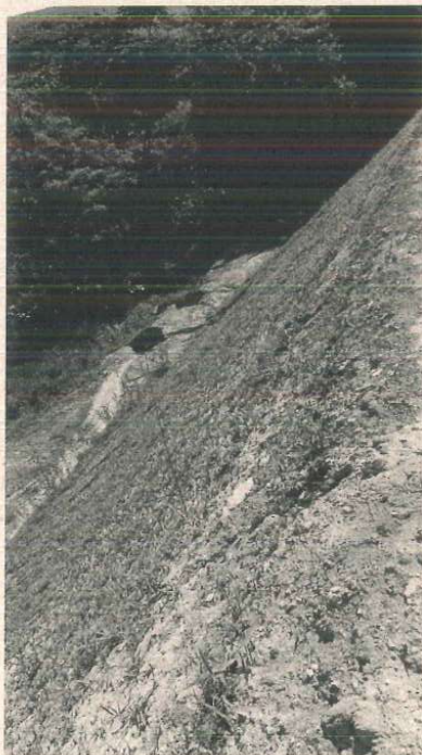
Hidrossemeadura implantada em todo o talude
