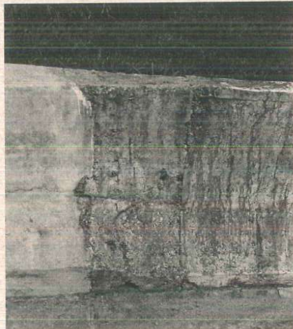
Vista oposta da fenda, do lado interno da pista, onde está completamente fechada, impedindo a passagem de água.
