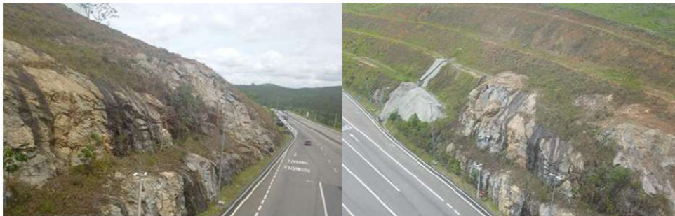
Figura 75: Talude 10 - Afloramento rochoso, concreto projetado e vegetação.
