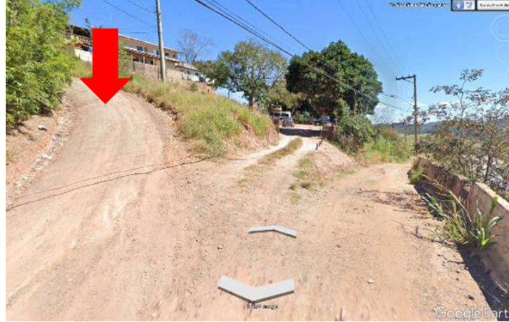
Figura 89: Situação atual – vista acesso 27.
