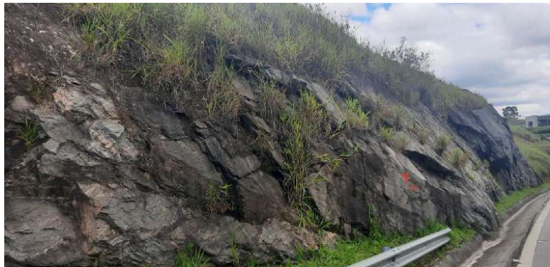
Figura 11: Talude 01 - Afloramento Rochoso.
