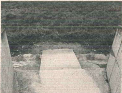
Vista de cima da rampa de concreto que foi implantada na saída do emboque da passagem de fauna do km 53+100.
