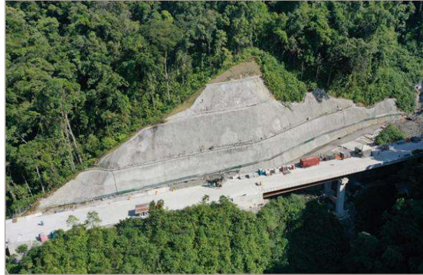
Figura 119 - Contenção tipo solo grampeado.
