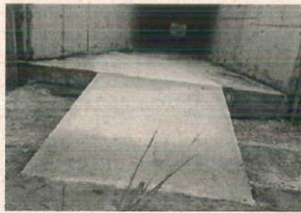
Detalhe da rampa de concreto implantada na saída do emboque da passagem de fauna.
