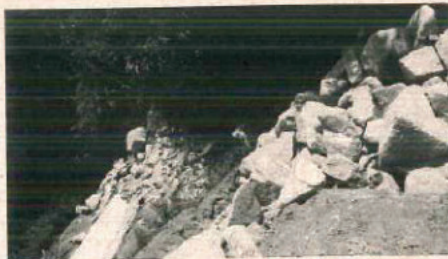
Blocos de rocha instalados no sistema de drenagem
