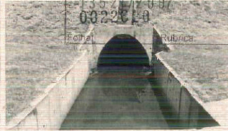
Foto atual da passagem de fauna do km 14+300. Apesar do nível d'água, é possível observar a passarela lateral.
