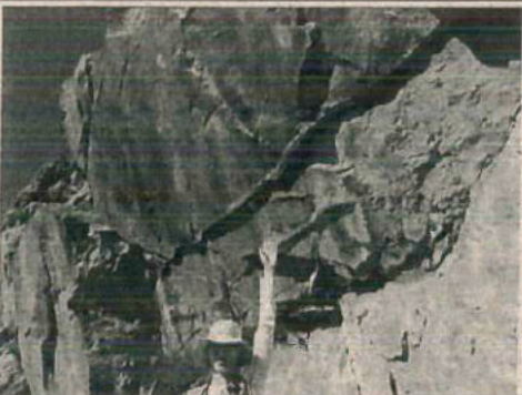
Foto 1.11. Executar medidas de estabilização de talude em rocha. Constatação de deslocamento dos blocos. Perigo de queda de blocos. (Km 32+800)
