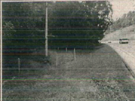
Foto 3.9. Adequar as cercas de direcionamento de fauna junto à passagem de fauna inferior no km 43+650, de acordo com a Norma DNIT 077/2006.
