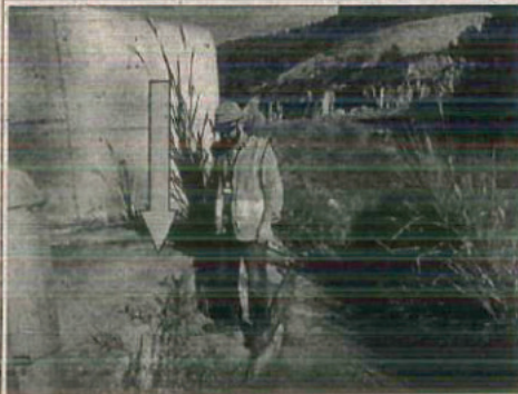
Fotos 3.19 e 3.20. Adequar entrada da passagem de fauna situada no km 53+100 (implantar passarela de concreto). O desnível existente (seta) dificulta ou não permite a entrada de animais.
