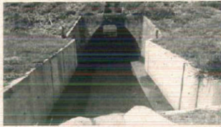
Foto de 2014, da época da conclusão das obras, mostra a passagem mais seca, bem como a passarela lateral.
