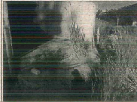
Fotos 3.19 e 3.20. Adequar entrada da passagem de fauna situada no km 53+100 (implantar passarela de concreto). O desnível existente (seta) dificulta ou não permite a entrada de animais.
