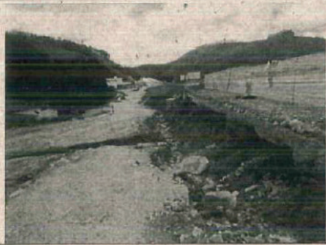
Foto 1.18. Instalar sistema de drenagem provisório e reforçar o acesso nas proximidades das obras complementares do km 36+800
