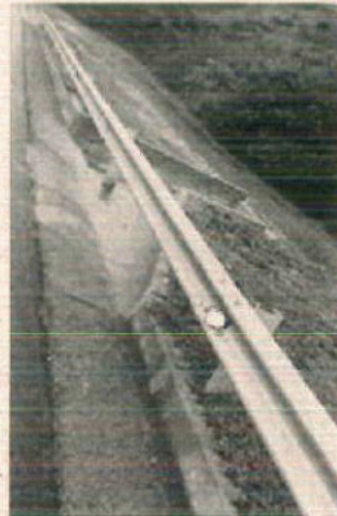
Foi realizado o direcionamento do fluxo de águas pluviais para caixa de contenção de produtos perigosos.
