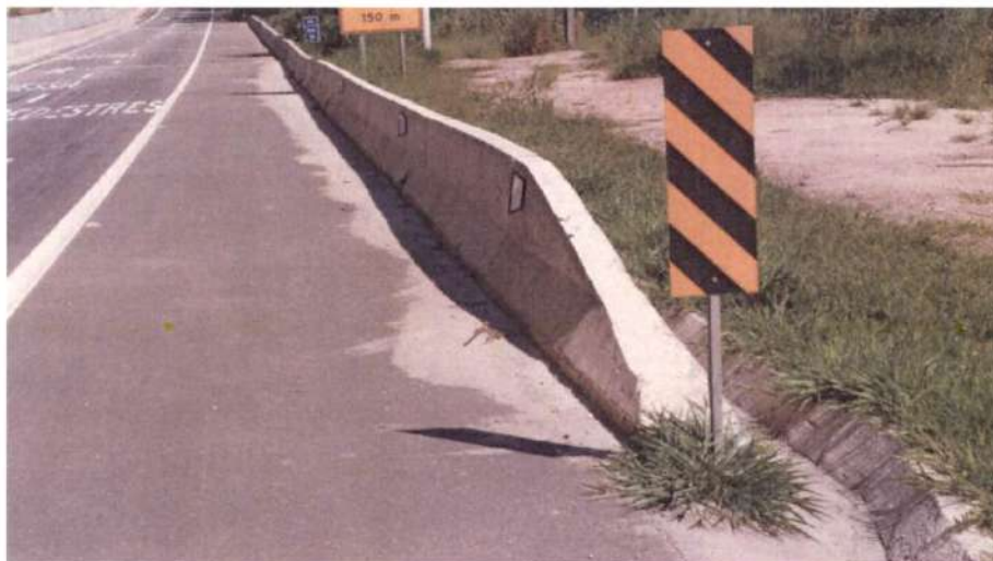
Barreira Rígida (Pendente adequação para instalação de tripla onda e atenuador de impacto)
